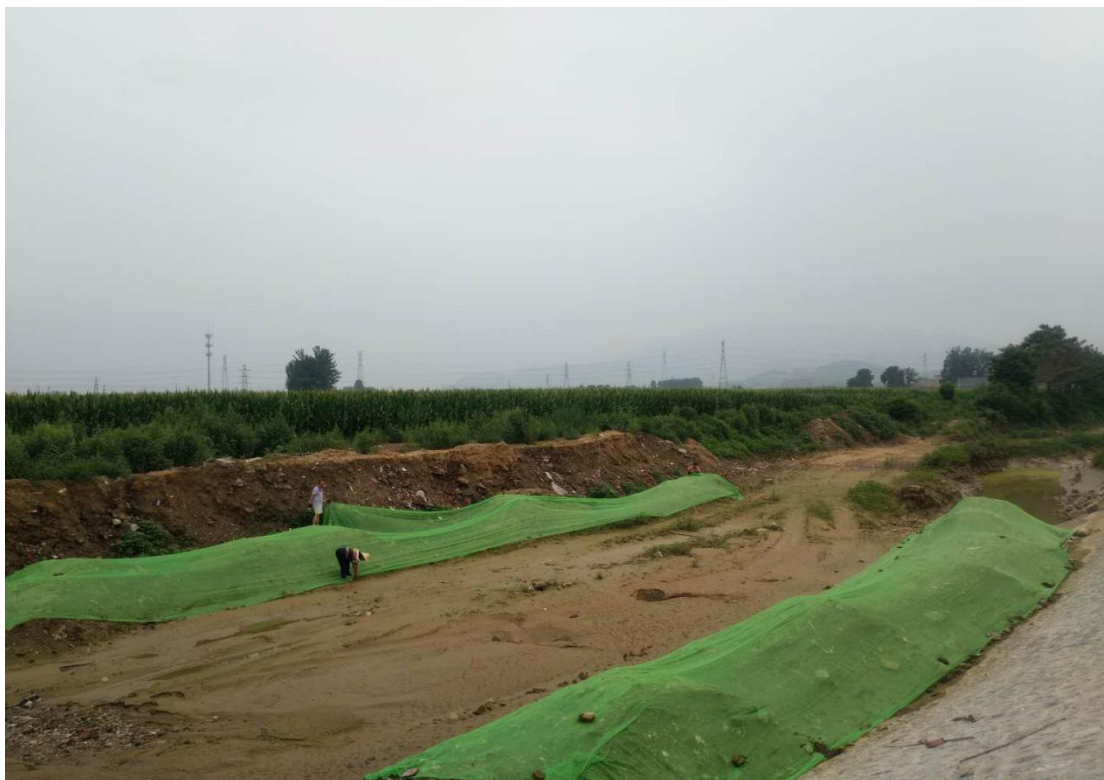
主体工程区临时遮盖
