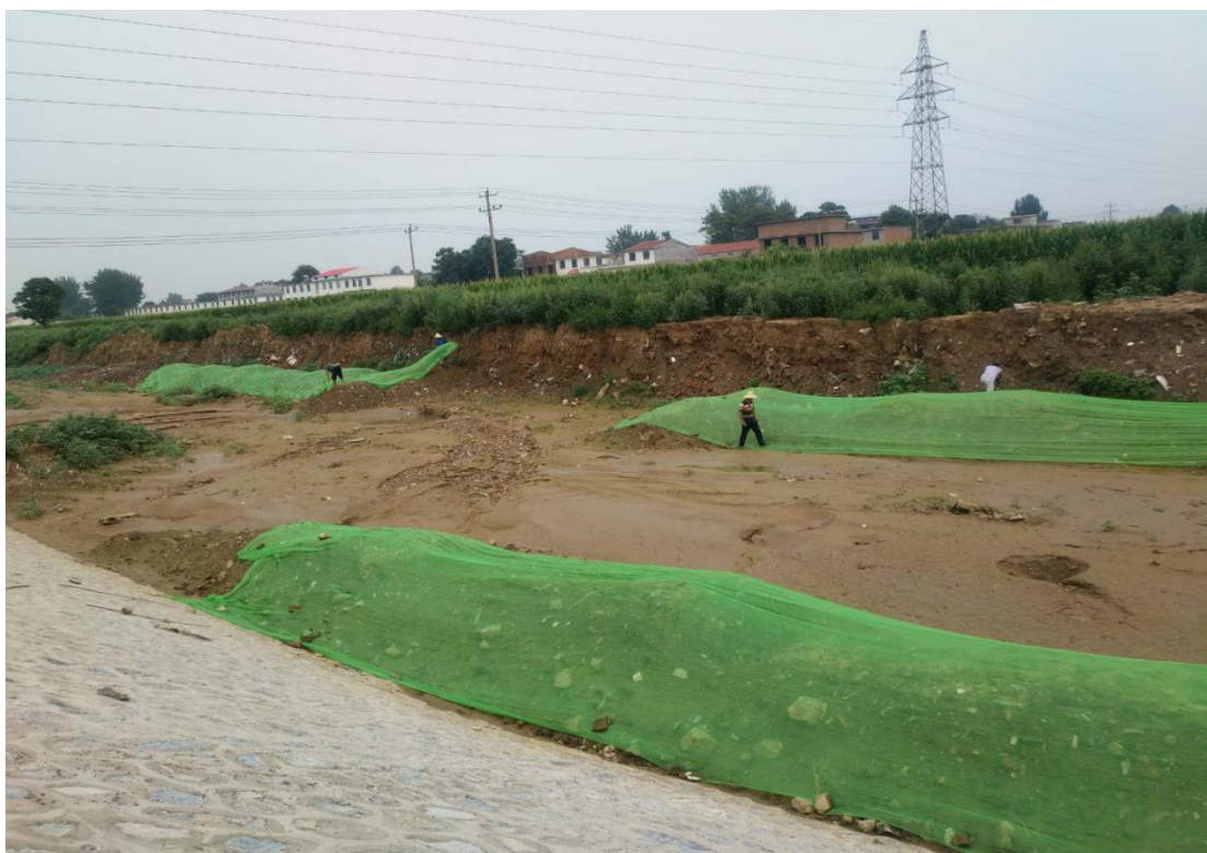
主体工程区临时遮盖
