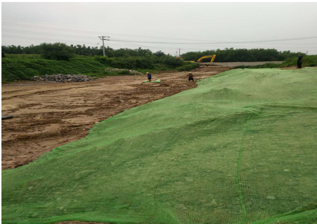
主体工程区临时遮盖
