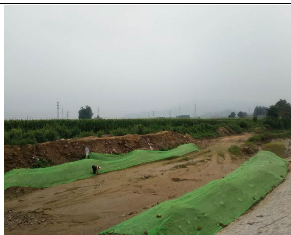
临时苫盖（2018年4月-2018年12月）
