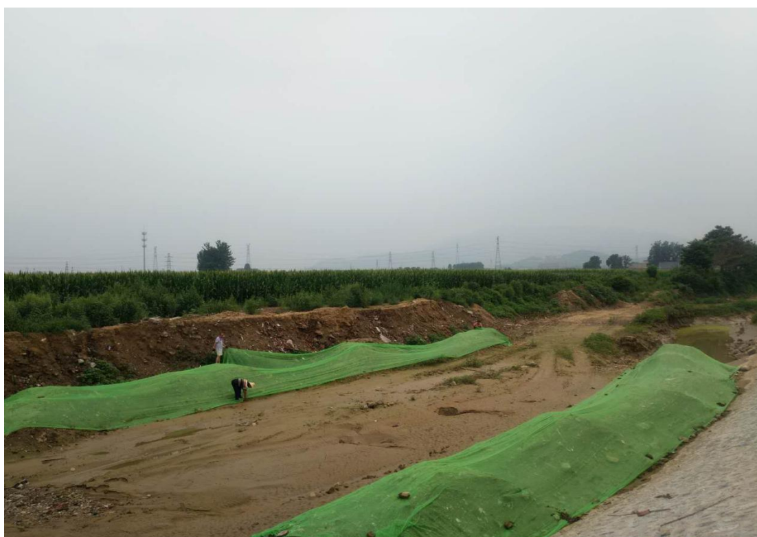
河道内临时堆土苫盖（拍摄时间：2018年7月）
