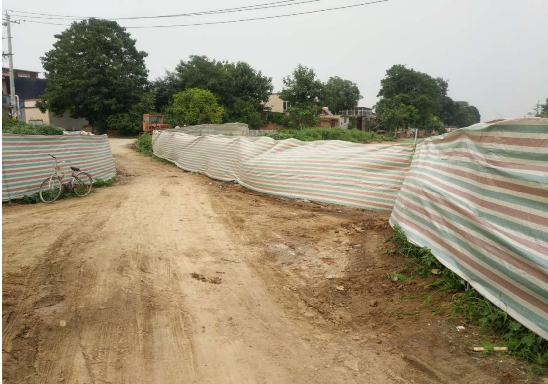
临时堆土彩布条围挡（拍摄时间：2018 年 7 月）
