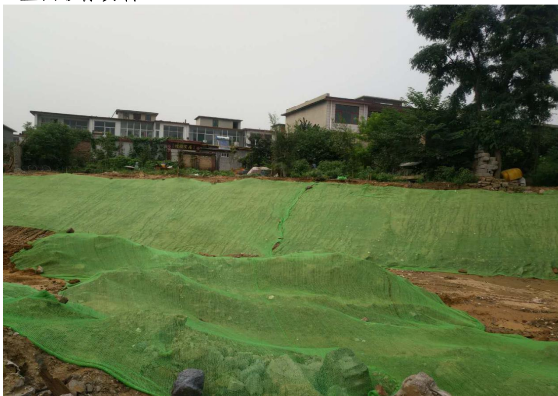
河道两侧苫盖（拍摄时间：2018年6月）
