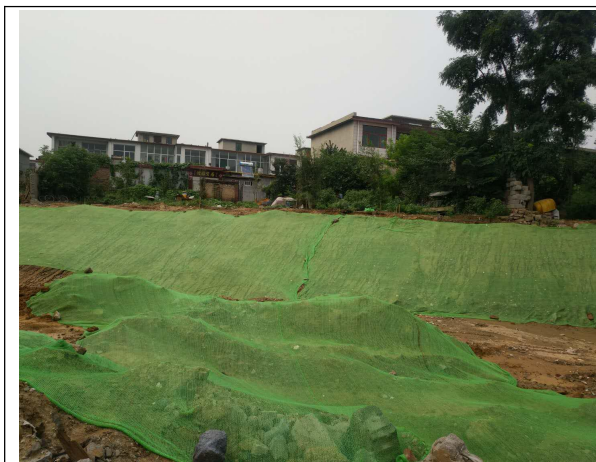
临时苫盖（2018年4月-2018年12月）
