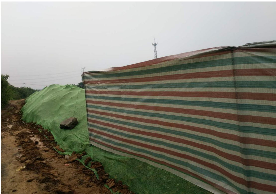
临时堆土彩布条围挡（拍摄时间：2018 年 8 月）
