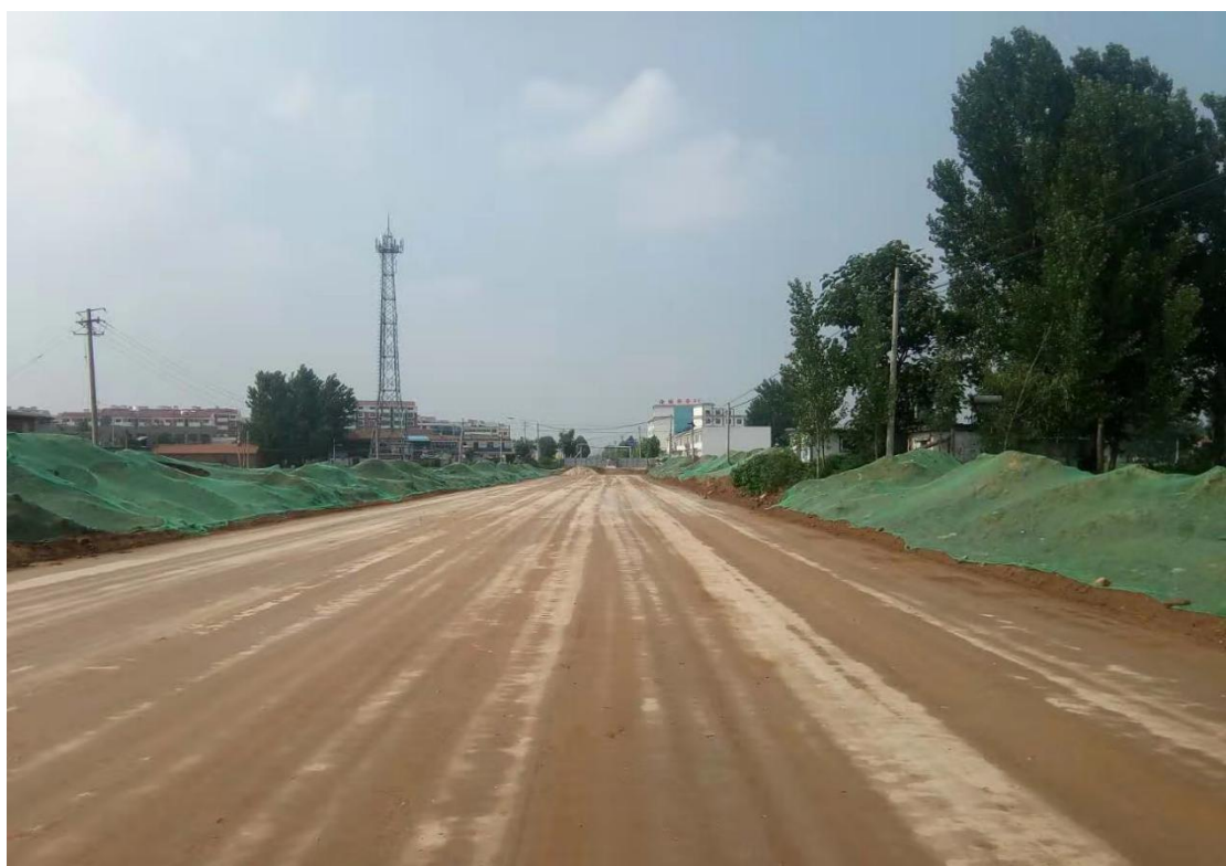
临时遮盖（拍摄时间：2013年11月）
