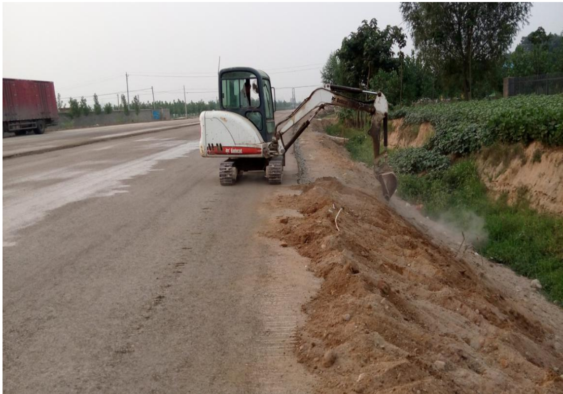
路肩挡水土埂（拍摄时间：2013年9月）
