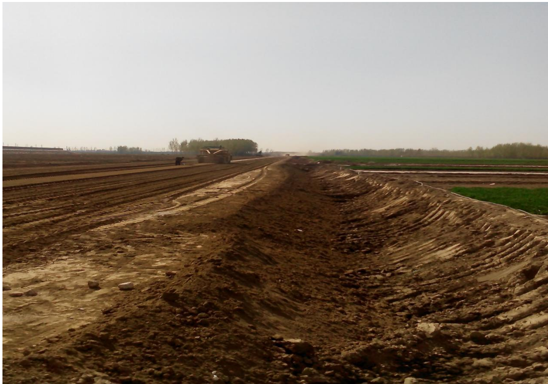
临时排水沟（拍摄时间：2013年4月）
