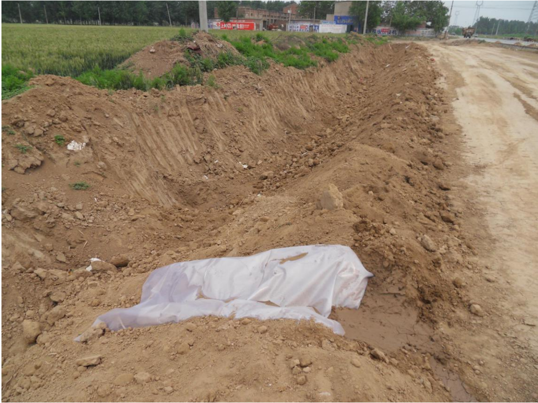
排水沟、排水槽及薄膜铺设（拍摄时间：2013年2月）
