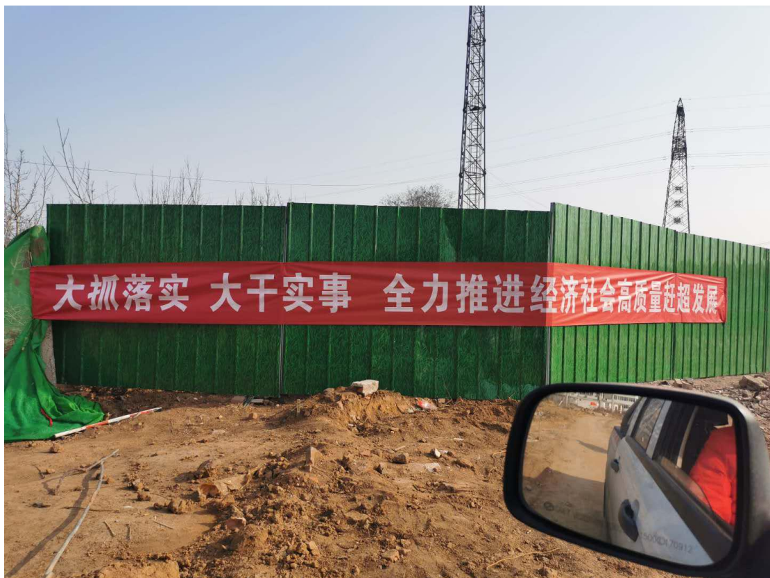
彩钢板拦挡（拍摄时间：2013年5月）
