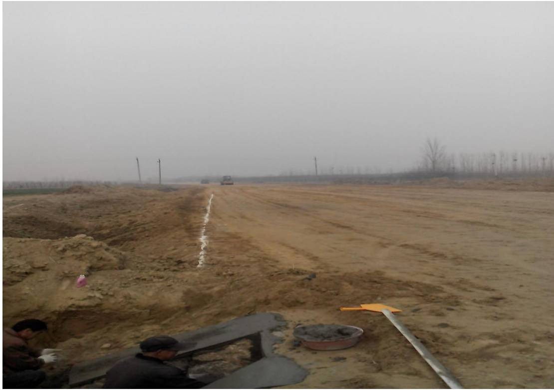
临时排水沟（拍摄时间：2013年4月）
