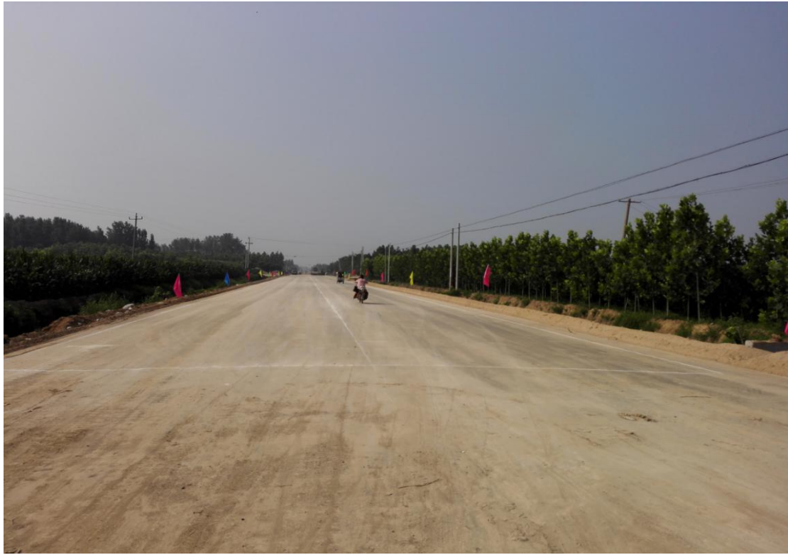
路肩挡水土埂（拍摄时间：2013年10月）
