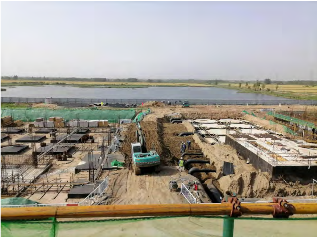
雨水收集池施工（拍摄时间：2020年9月）
