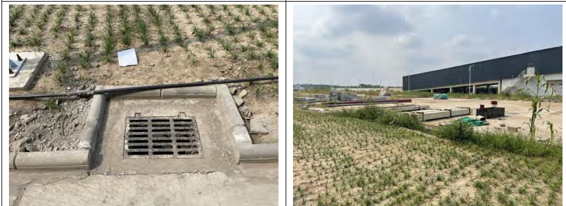
道路管线及广场工程-雨水管网
