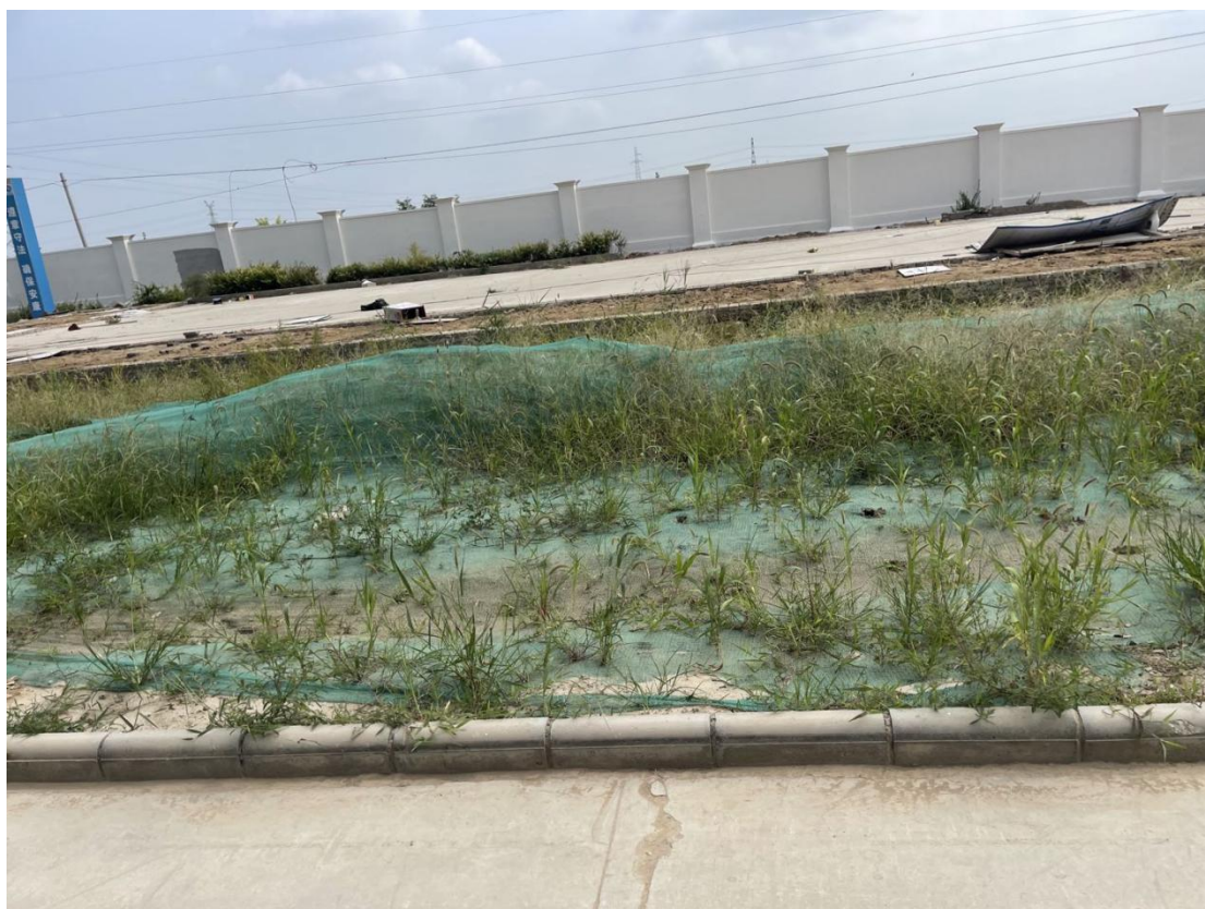
绿化苫盖（拍摄时间：2021年6月）
