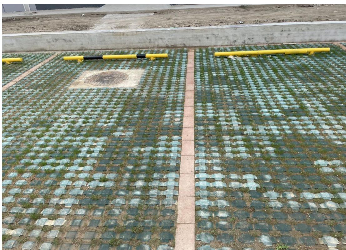
植草砖铺装（拍摄时间2021.9）
