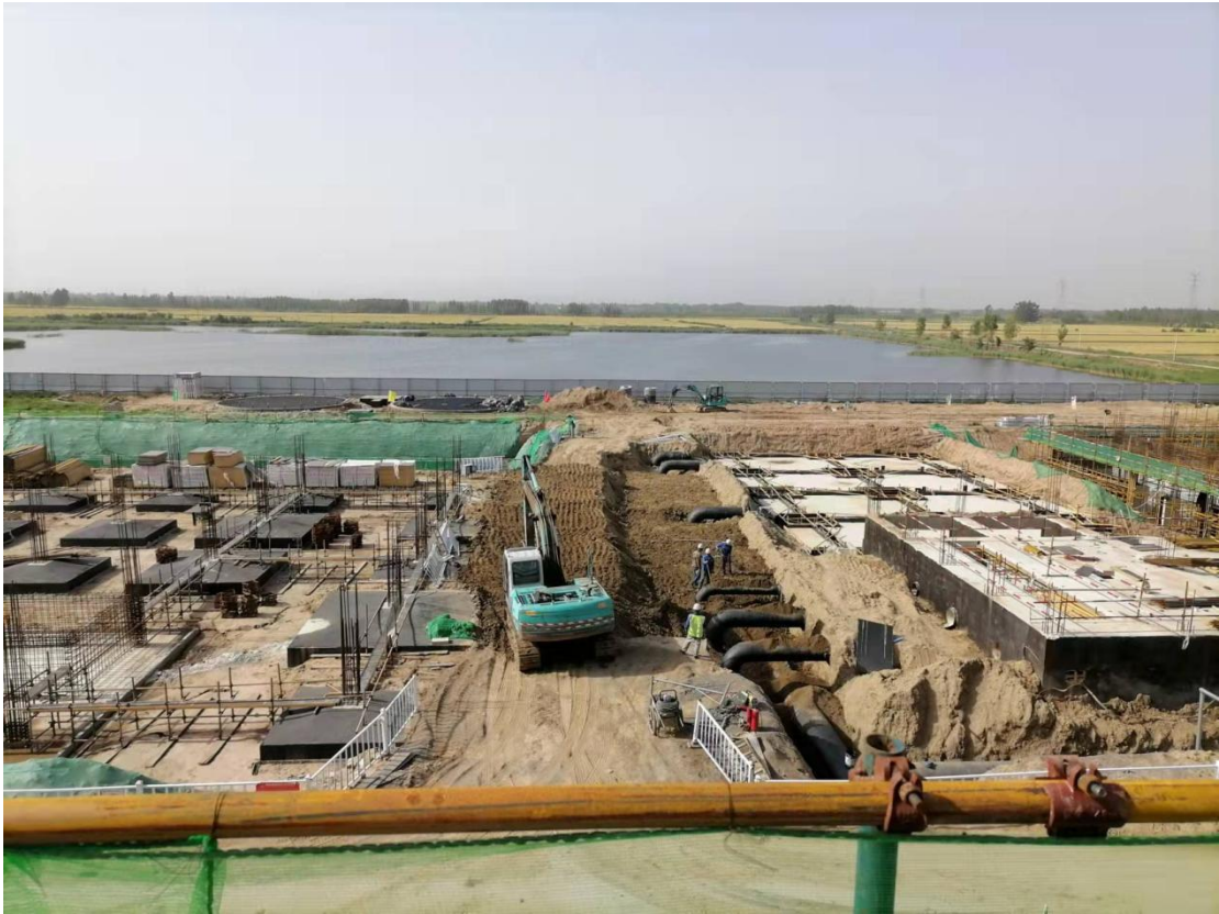
雨水收集池施工（拍摄时间：2020年9月）
