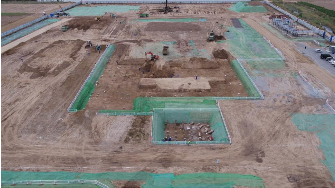
建构筑物工程临时遮盖（拍摄时间：2019年11月）
