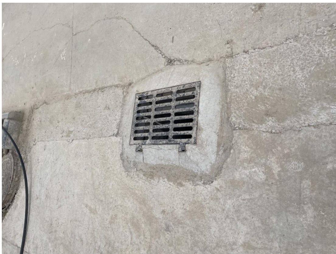
雨水管网（拍摄时间：2021年9月）
