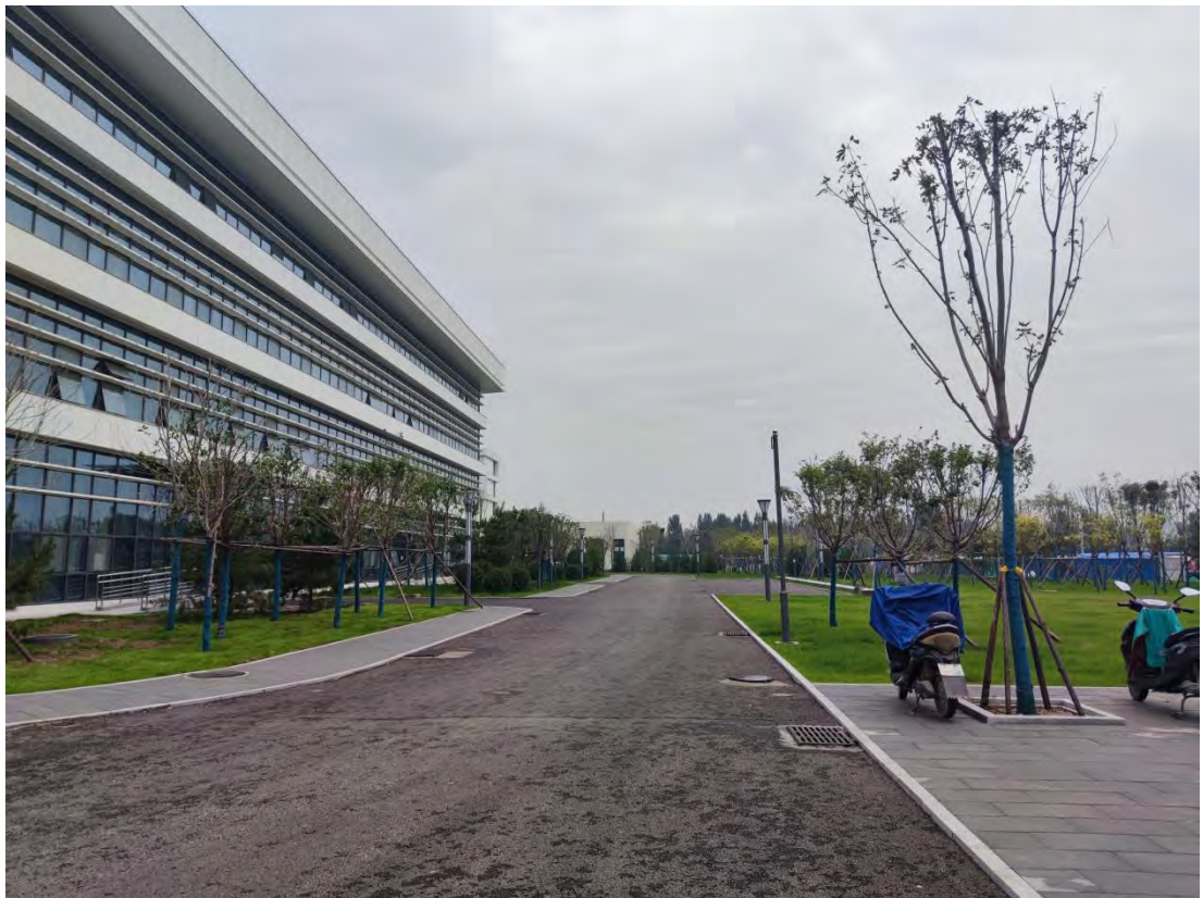
雨水管网（拍摄时间：2021年10月）
