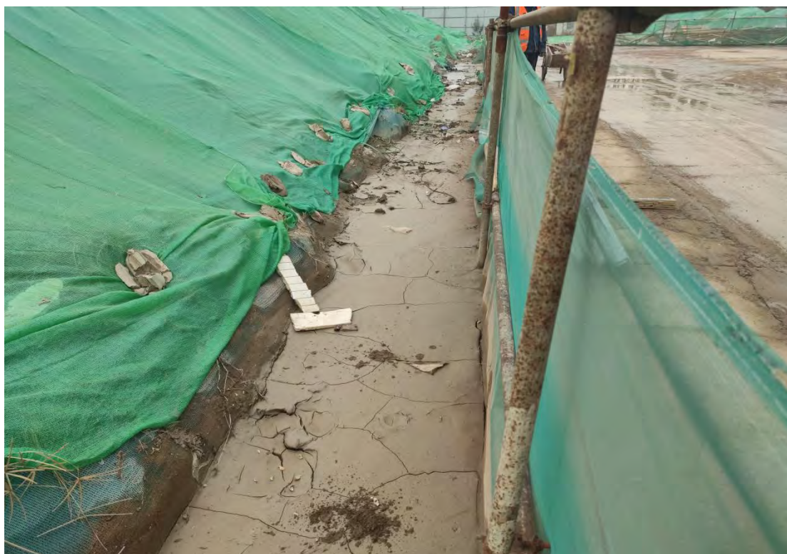
临时排水沟（拍摄时间：2021年2月）
