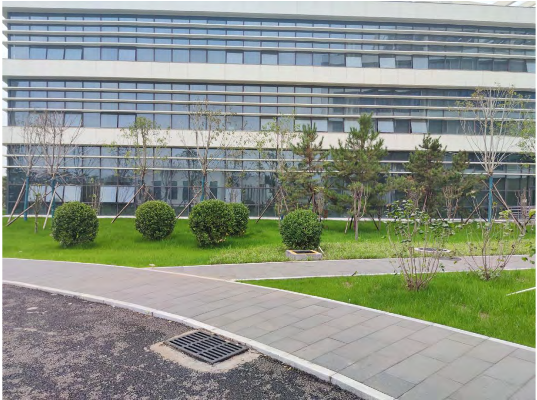
雨水管网（拍摄时间：2021年10月）
