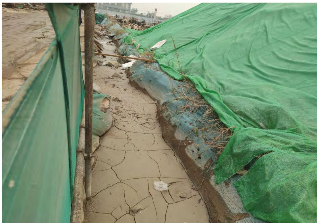
临时排水沟（拍摄时间：2021年2月）
