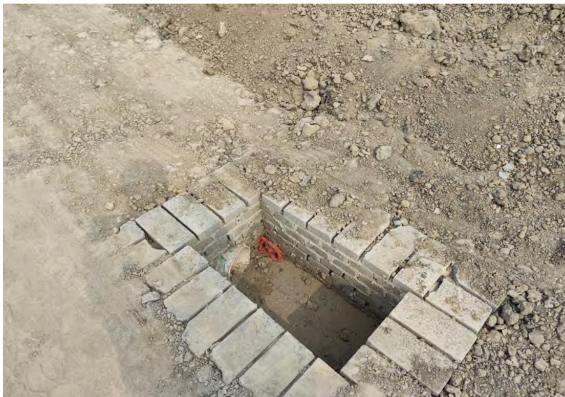
修建排水管网
