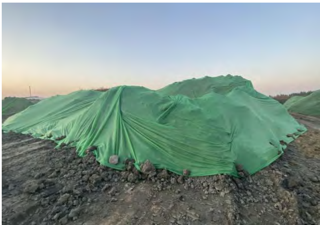
临时堆土防尘网遮盖
