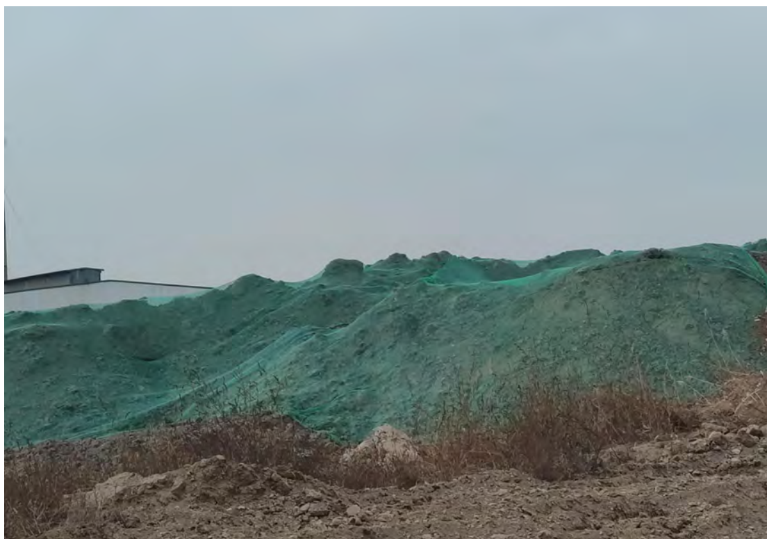
临时堆土防尘网遮盖
