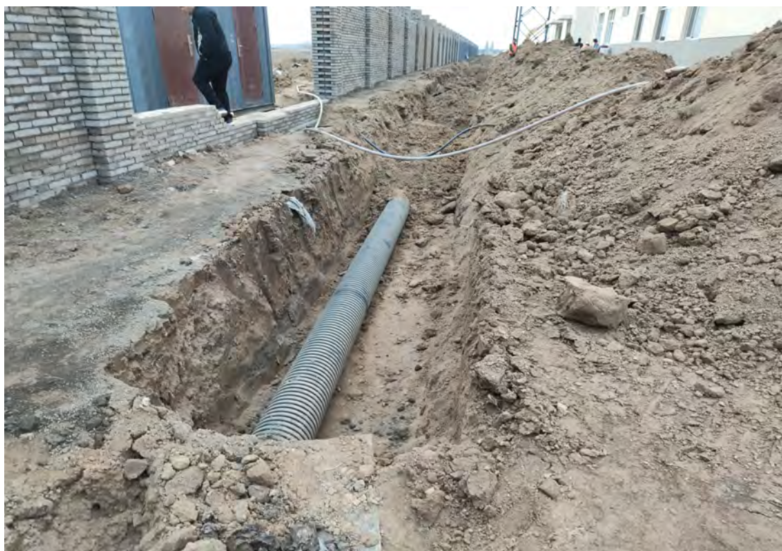
排水管网管沟开挖
