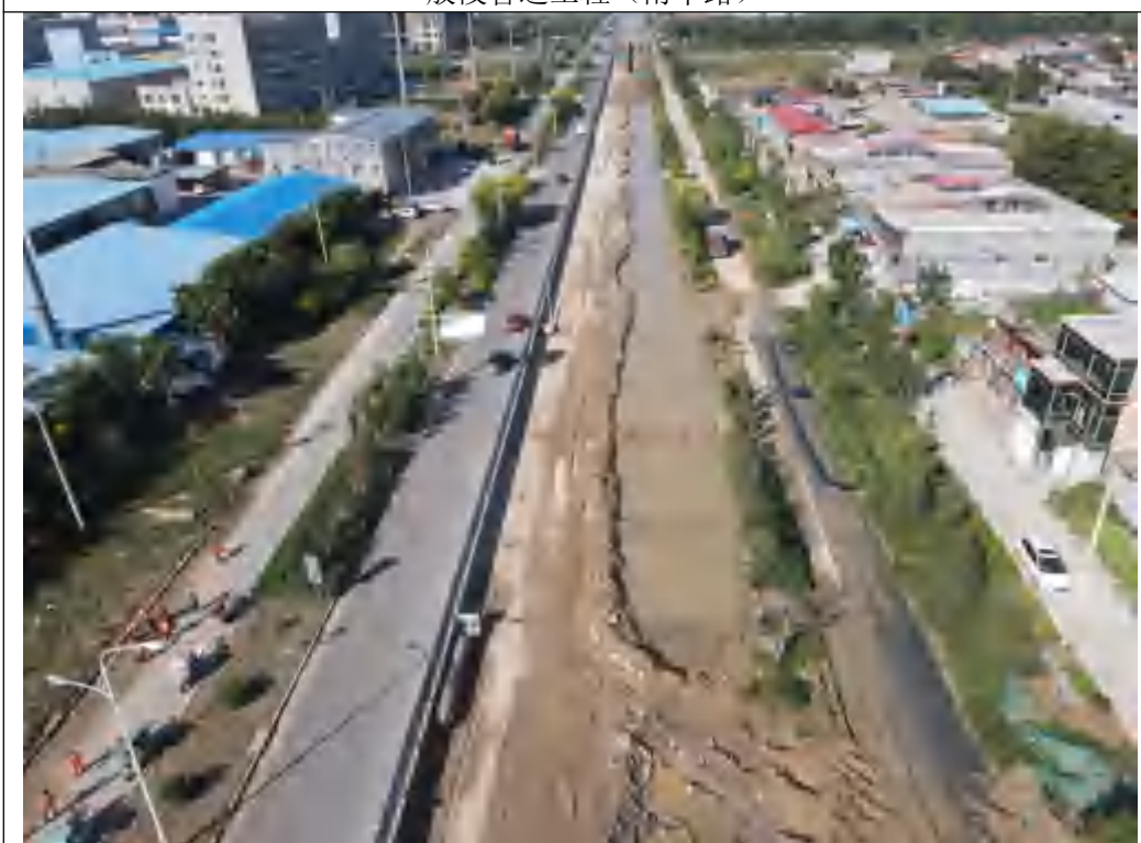
一般段管道工程（南车路）
