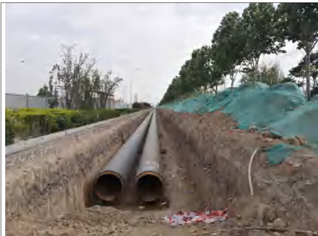
一般段管道工程（裕翔街）
