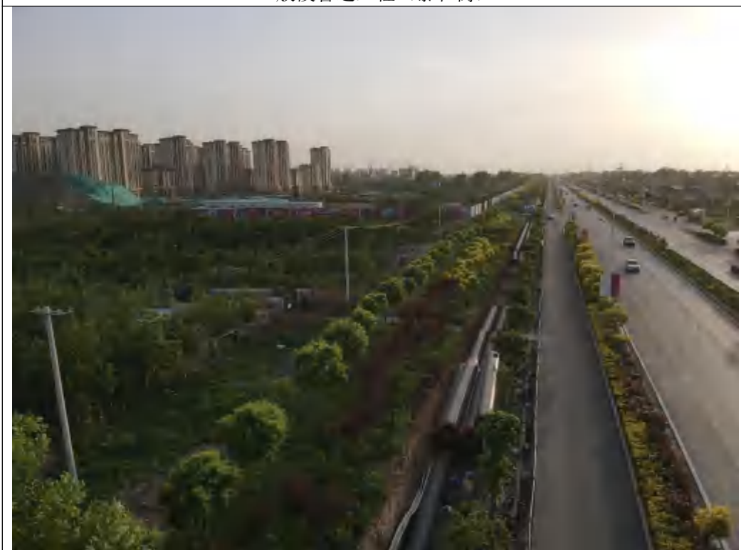
一般段管道工程（衡井路）
