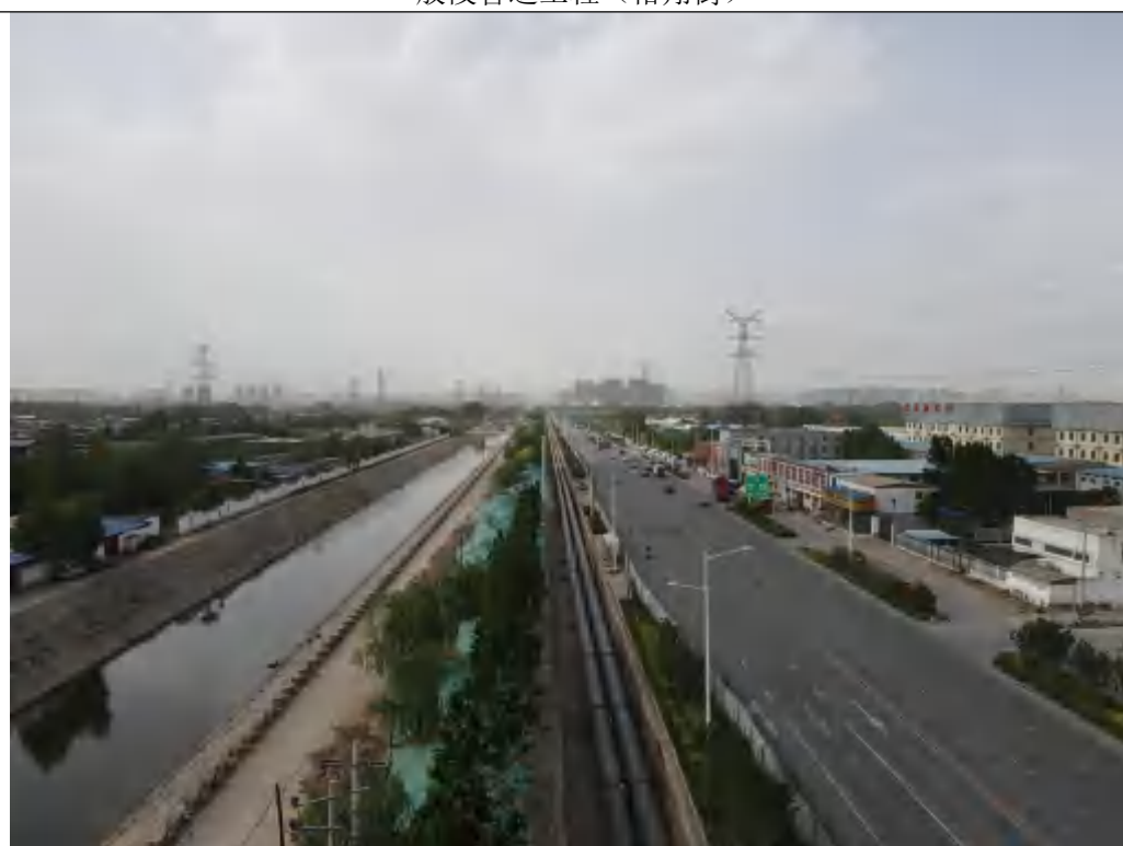
一般段管道工程（裕翔街）
