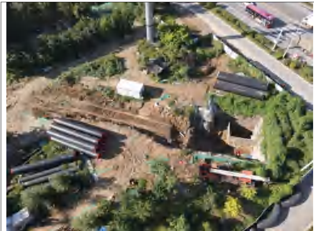
穿越工程（顶管穿越裕翔街）
