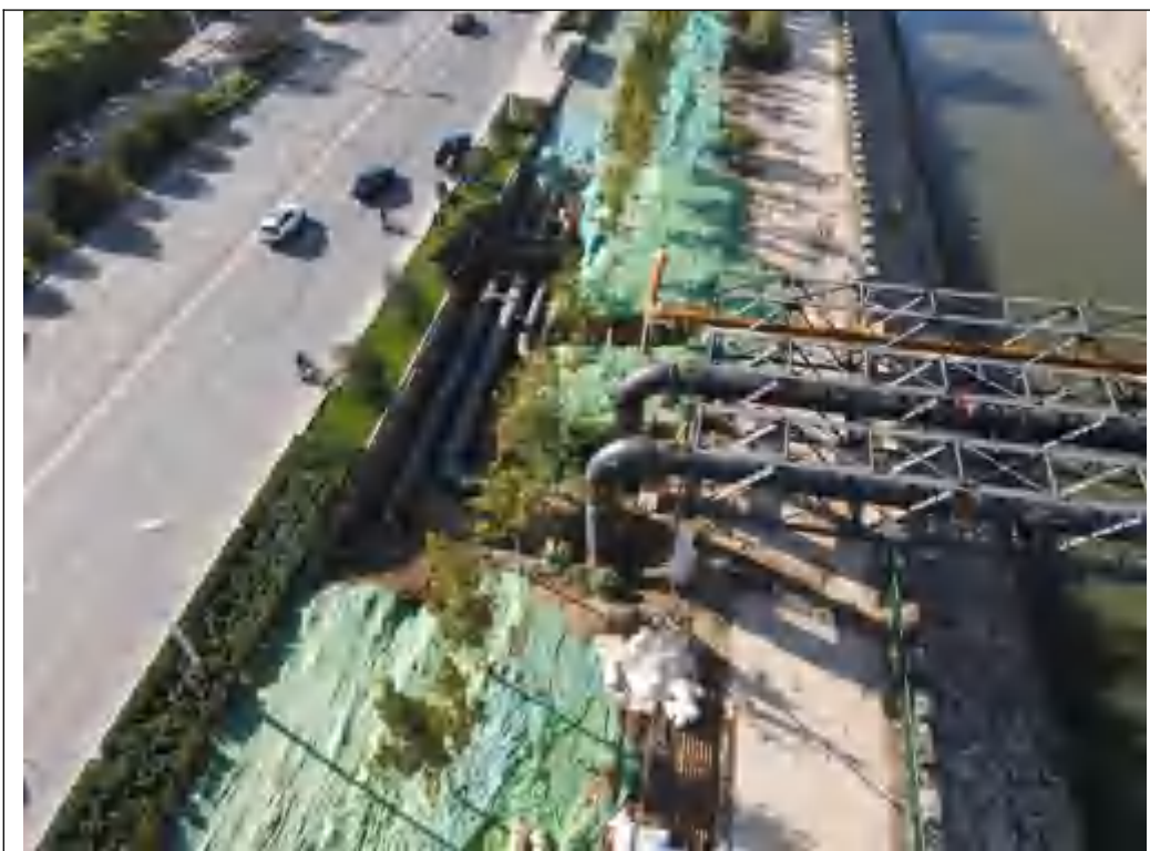
穿越工程（桁架穿越民心河）
