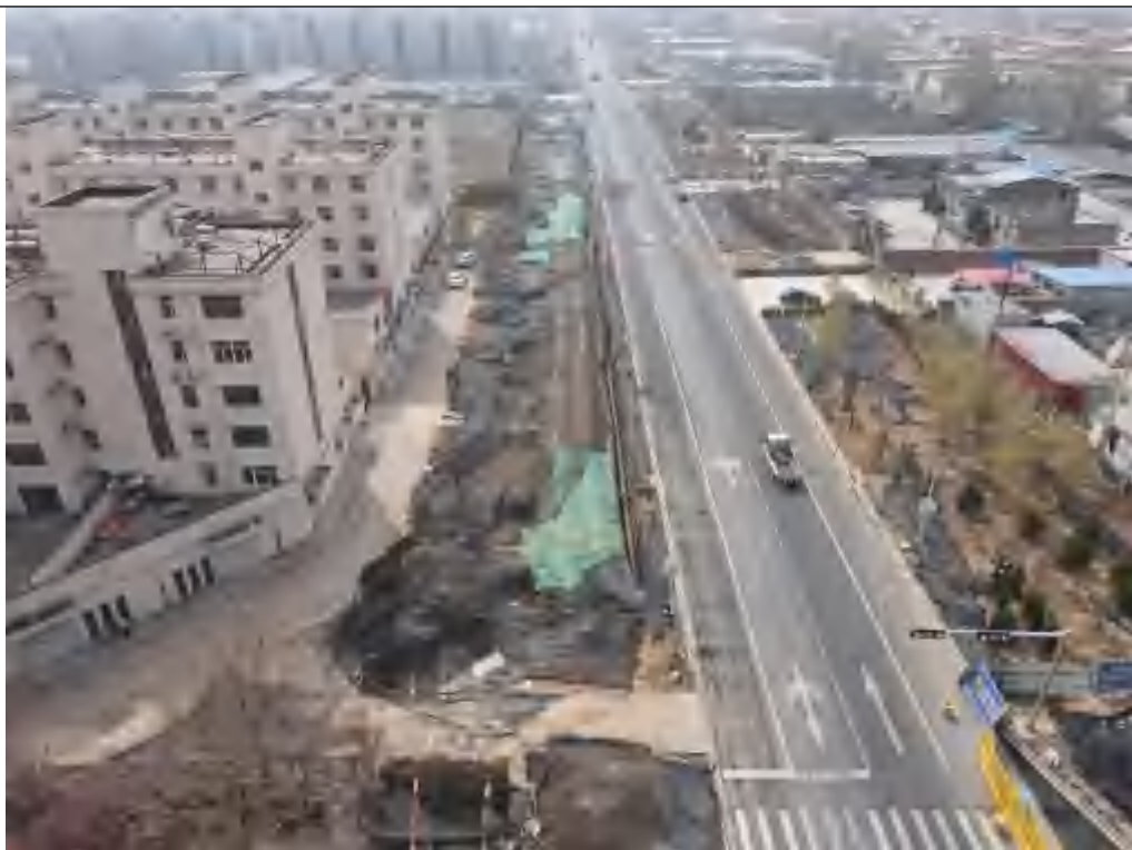
一般段管道工程（环城西路）
