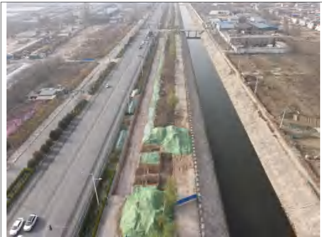
一般段管道工程（裕翔街）
