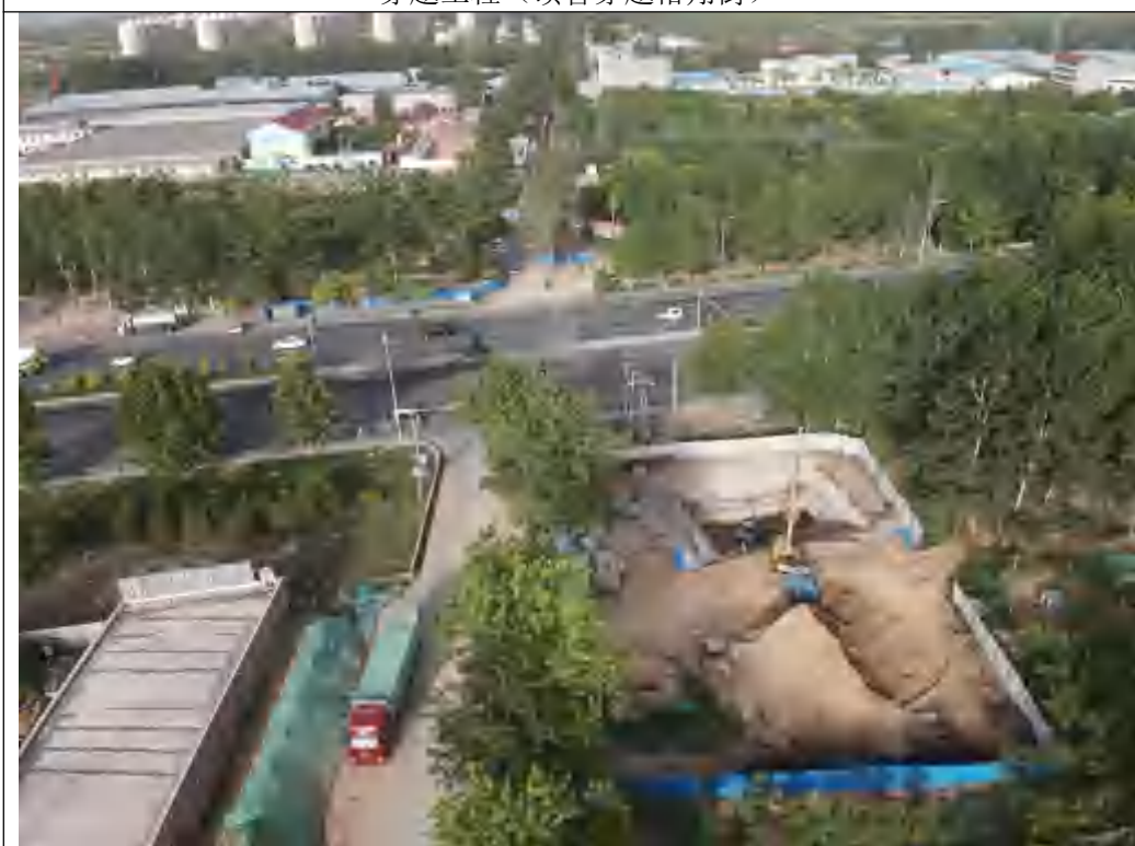
穿越工程（顶管穿越 308 国道）
