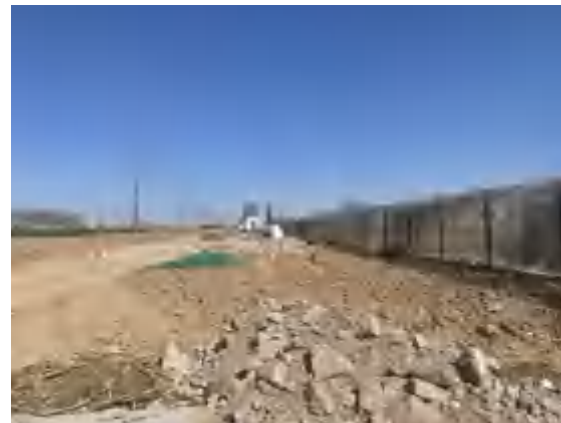
南车路管线下方裸露
