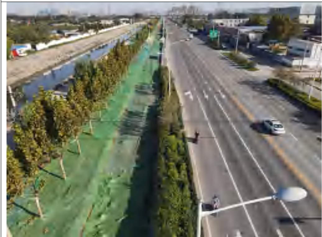
一般段管道工程（裕翔街）
