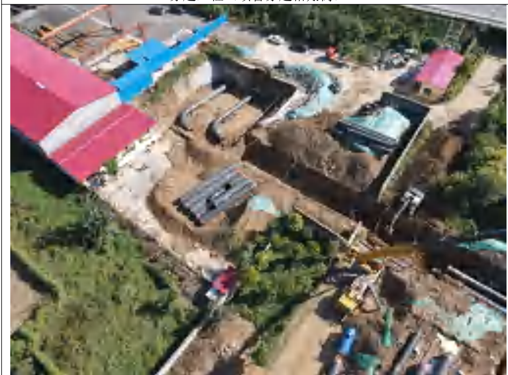
穿越工程（顶管穿越新元高速）
