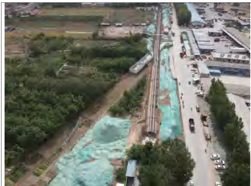
一般段管道工程（裕华热电厂外）
