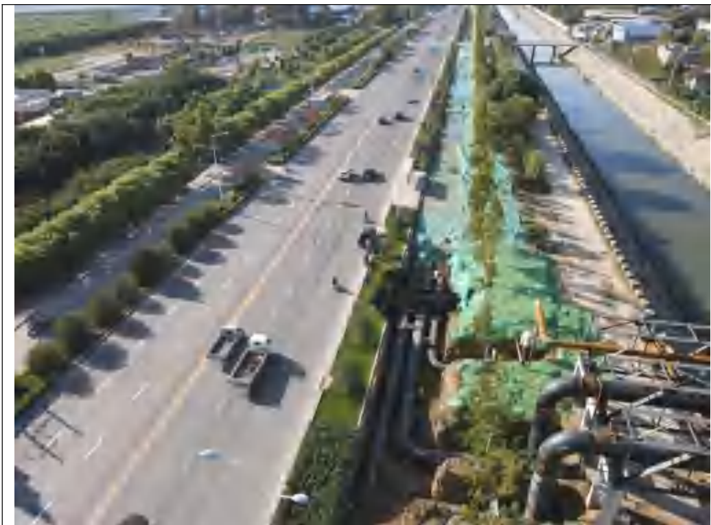
一般段管道工程（裕翔街）
