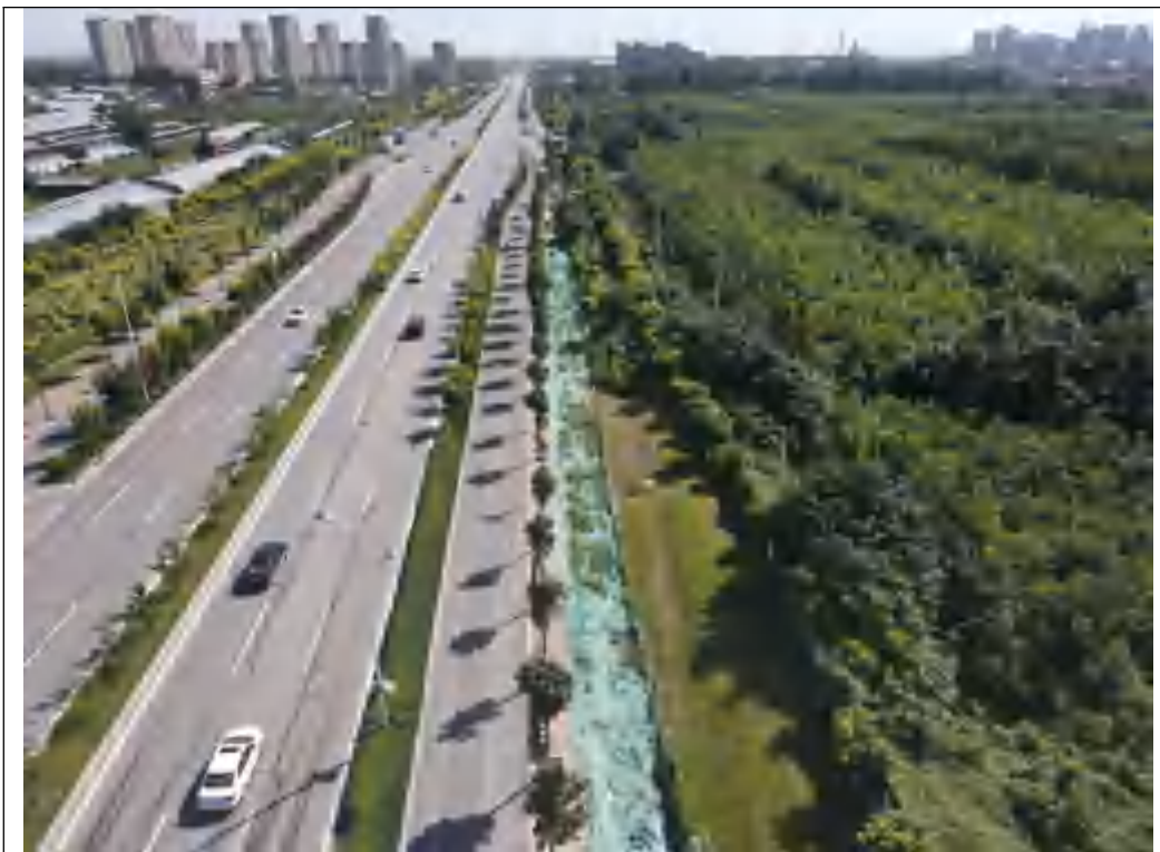
一般段管道工程（衡井路）
