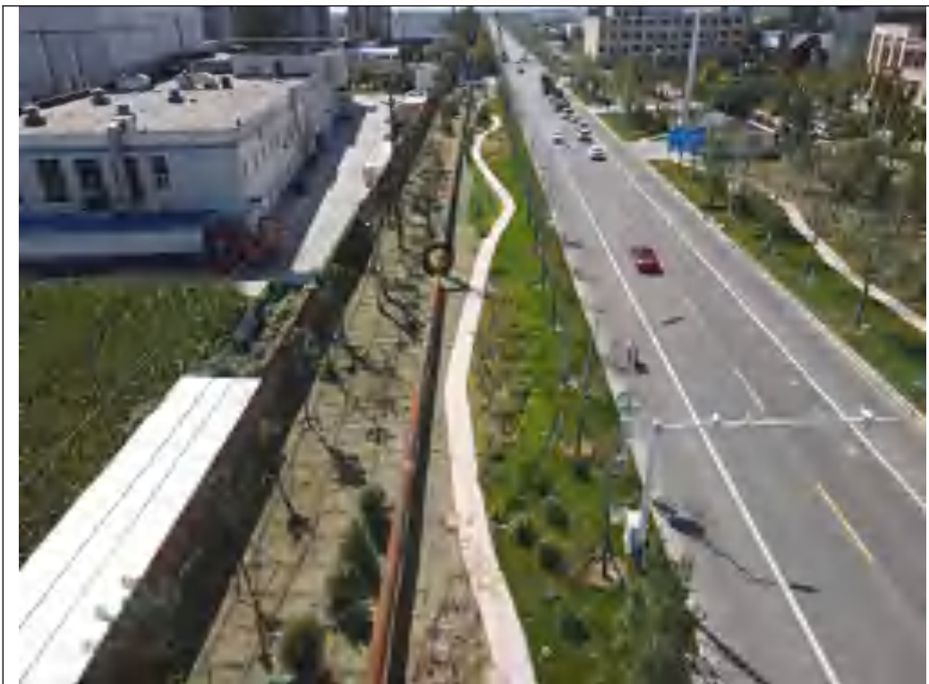
一般段管道工程（西城路）
