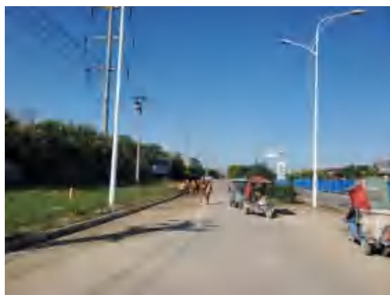
泥水冲出项目区外，保洁正在清理
