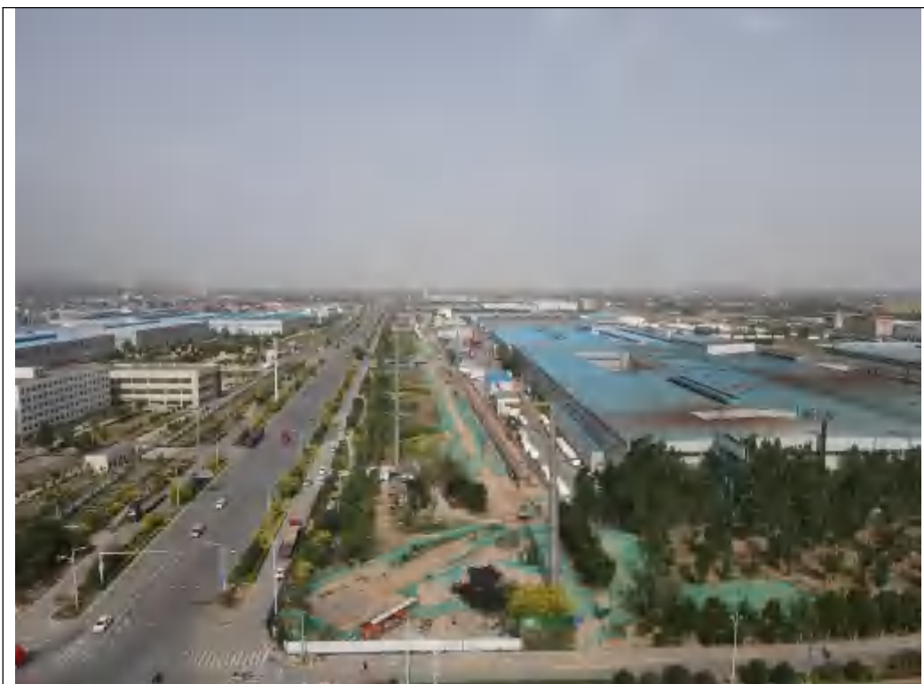
一般段管道工程（南车路）
