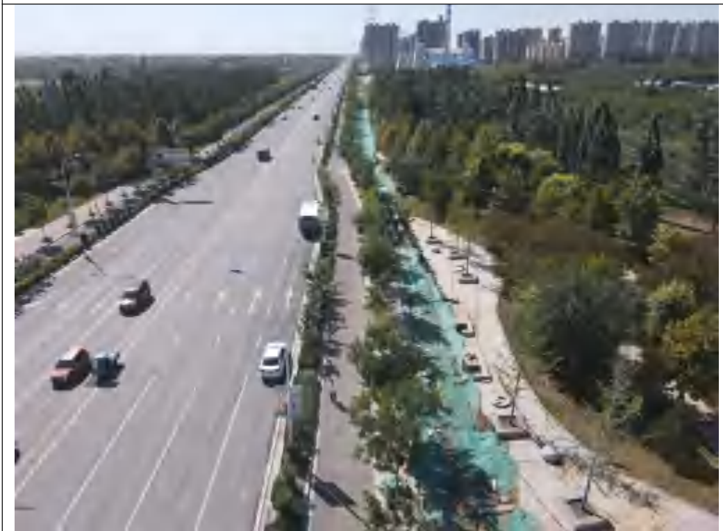
一般段管道工程（柴武大街）
