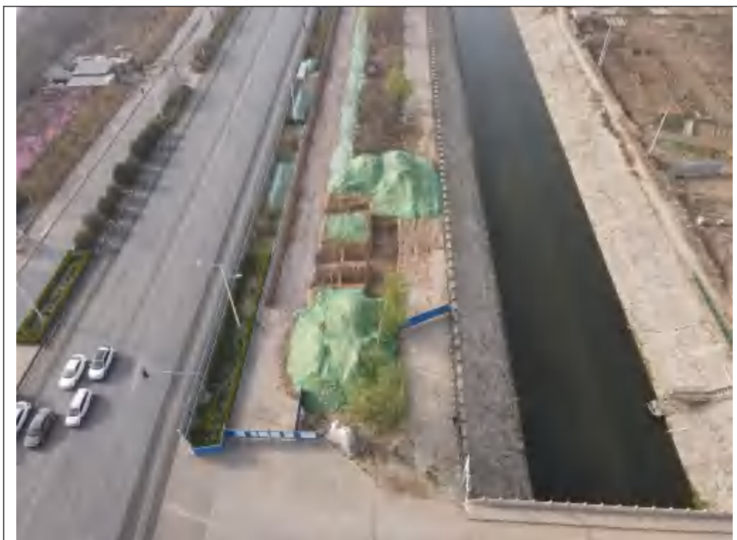
穿越工程（桁架穿越民心河）
