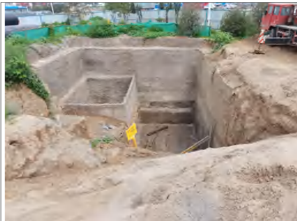
穿越工程（顶管穿越裕翔街）
