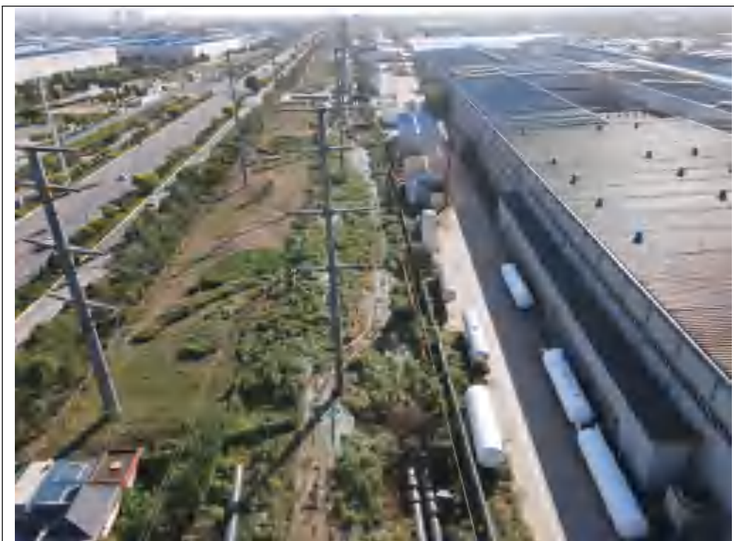
一般段管道工程（南车路）
