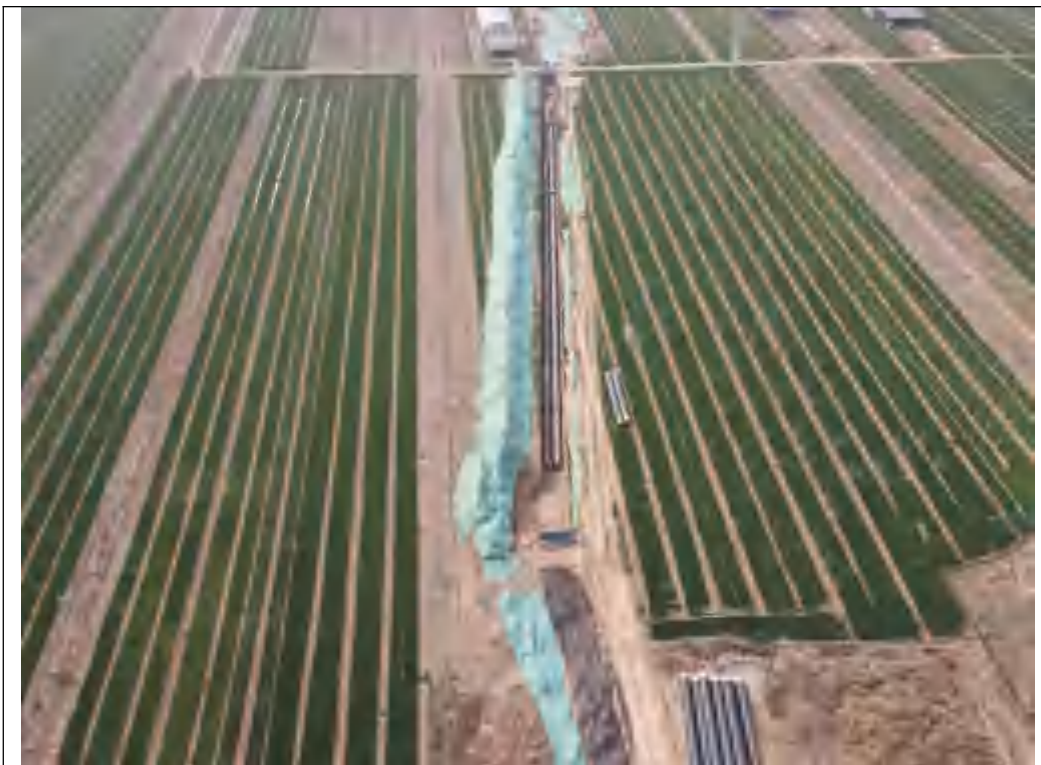
一般段管道工程（昌德街）
