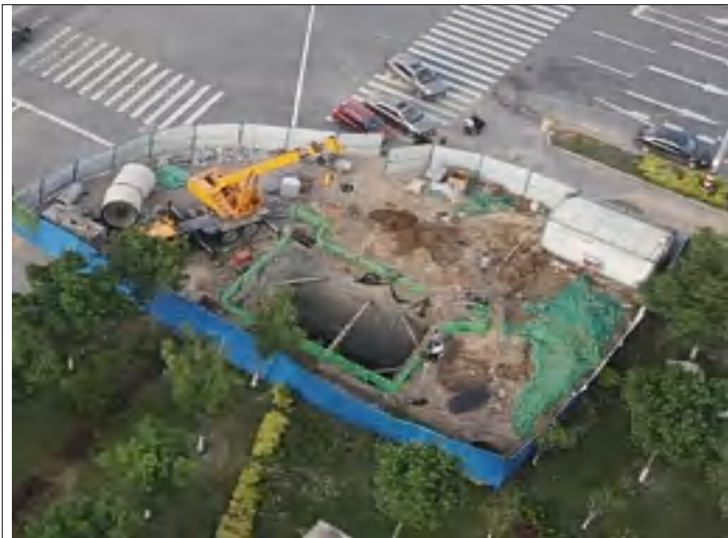
穿越工程（顶管穿越衡井路）
