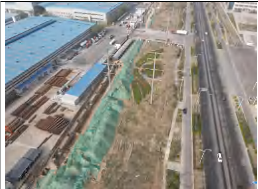
一般段管道工程（南车路）
