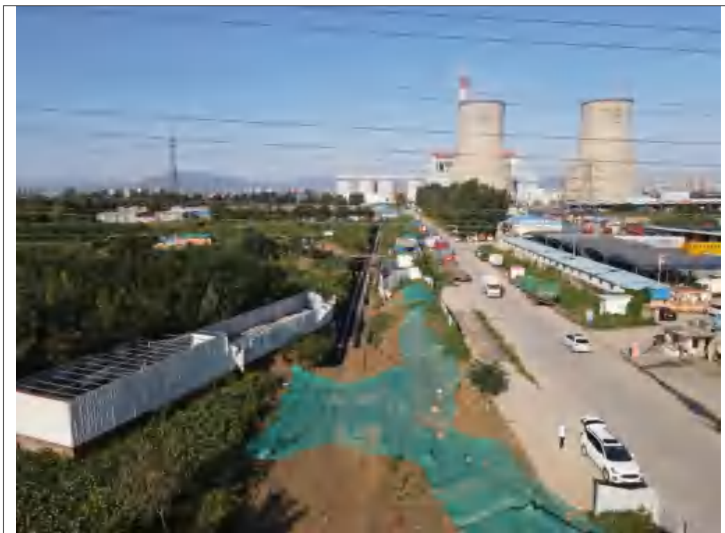
一般段管道工程（裕华热电厂外）
