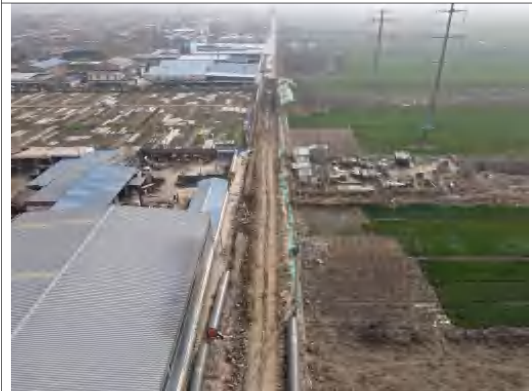
一般段管道工程（南车路）
