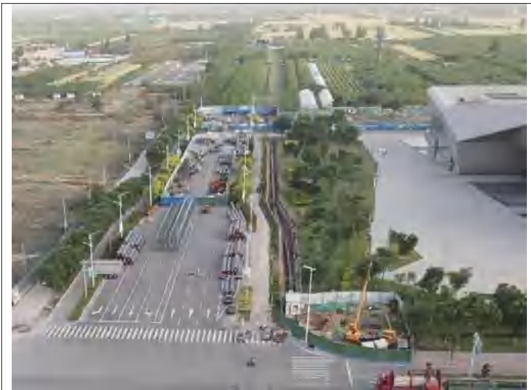
一般段管道工程（泰和街）
