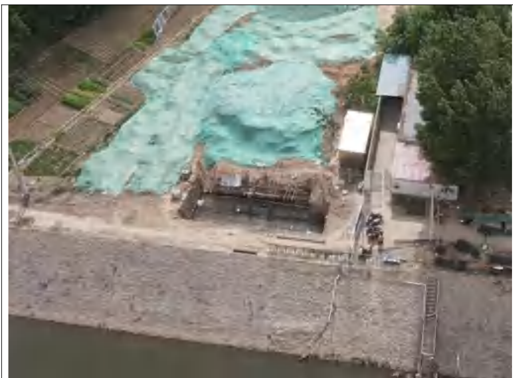
穿越工程（桁架穿越民心河）
