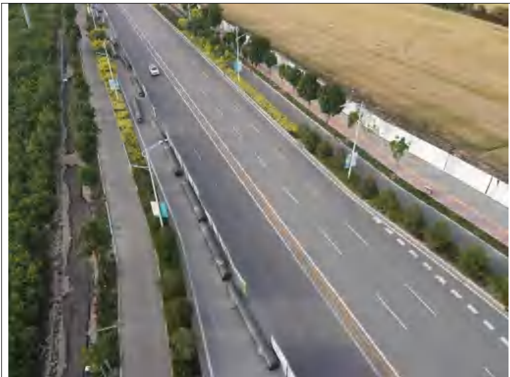
一般段管道工程（宏泰大街）
