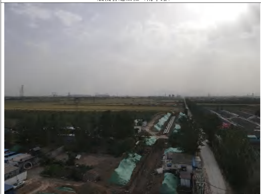
一般段管道工程（南车路）
