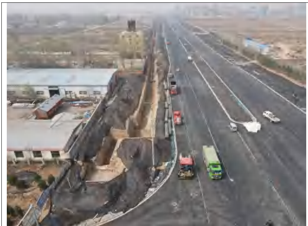
一般段管道工程（栾武路）
