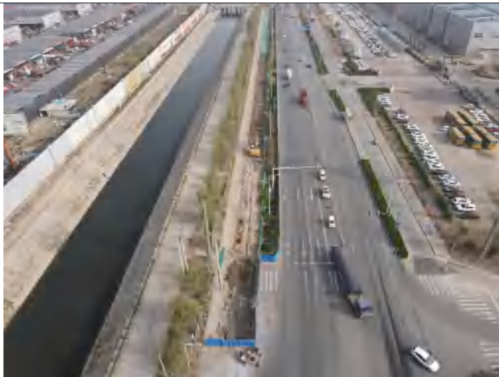
一般段管道工程（裕翔街）
