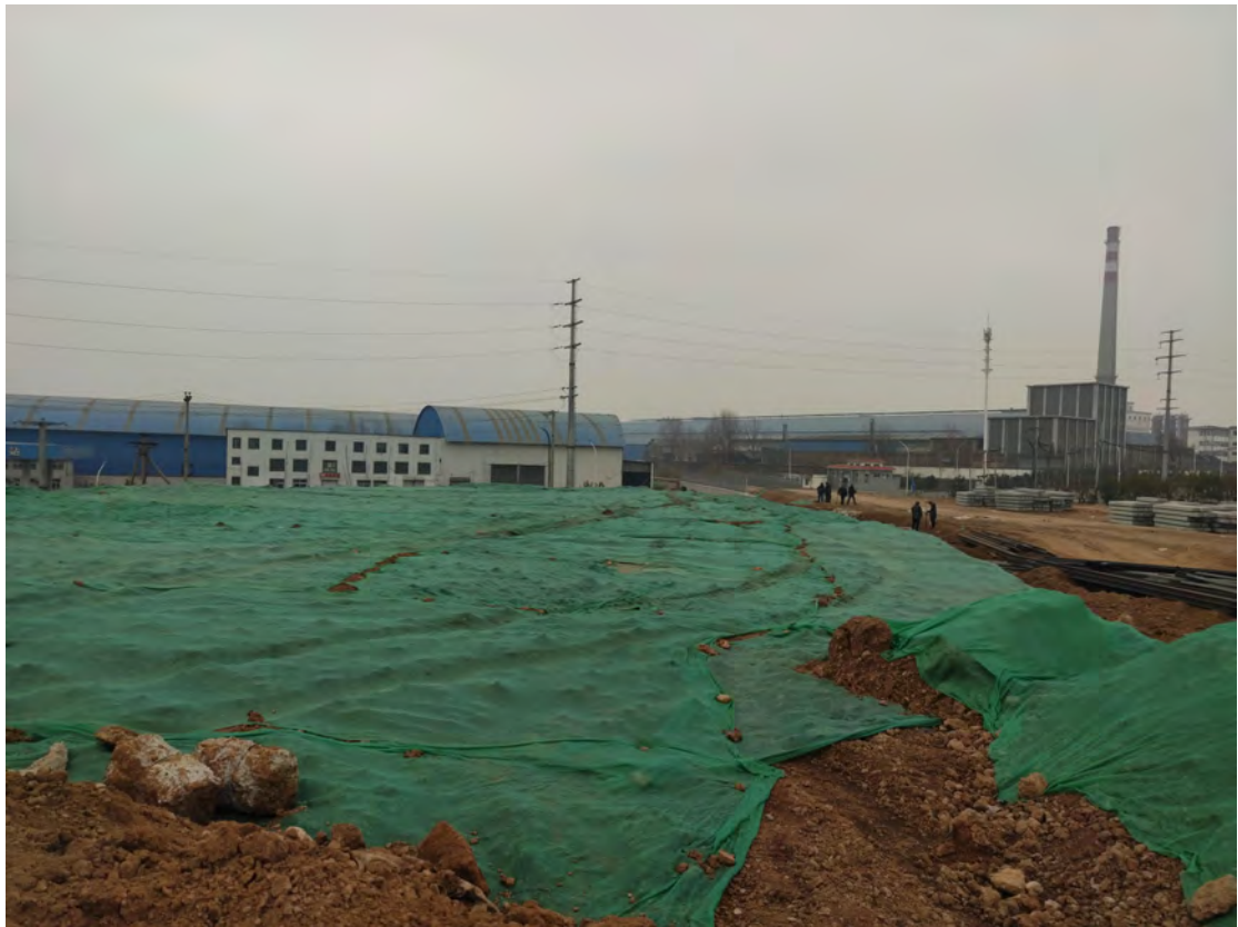
临时覆盖（铁路专用线，2020.06）
