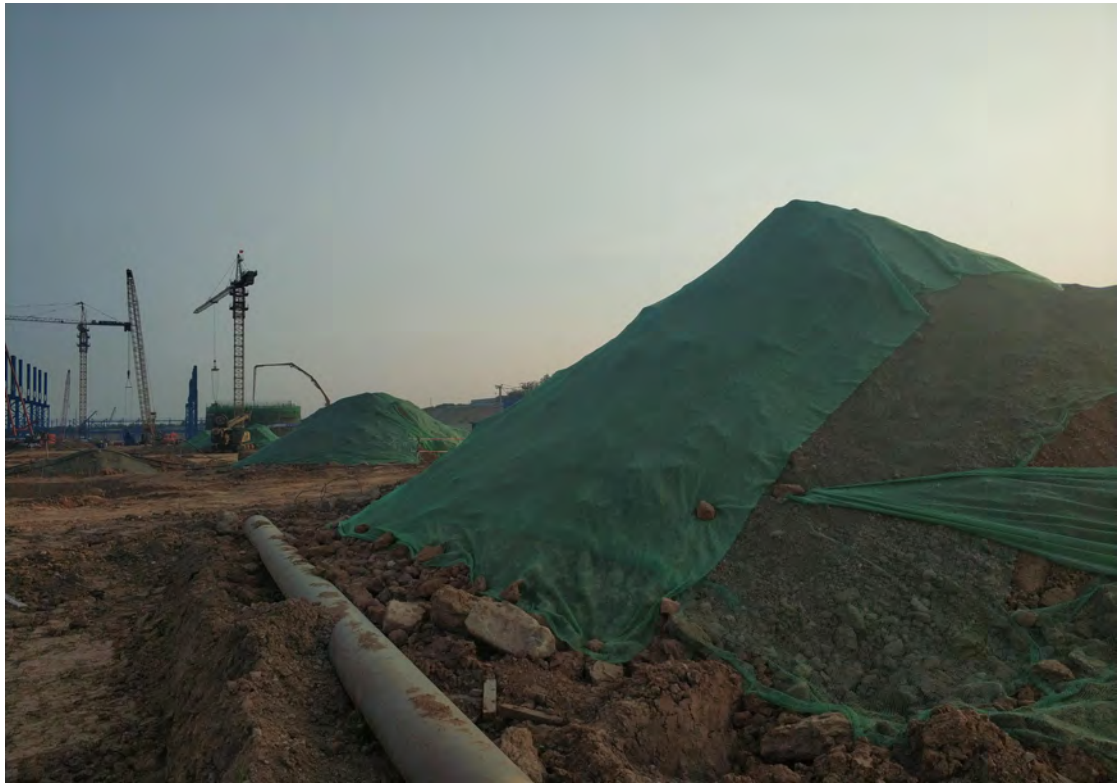
临时覆盖（主生产区，2019.07）
