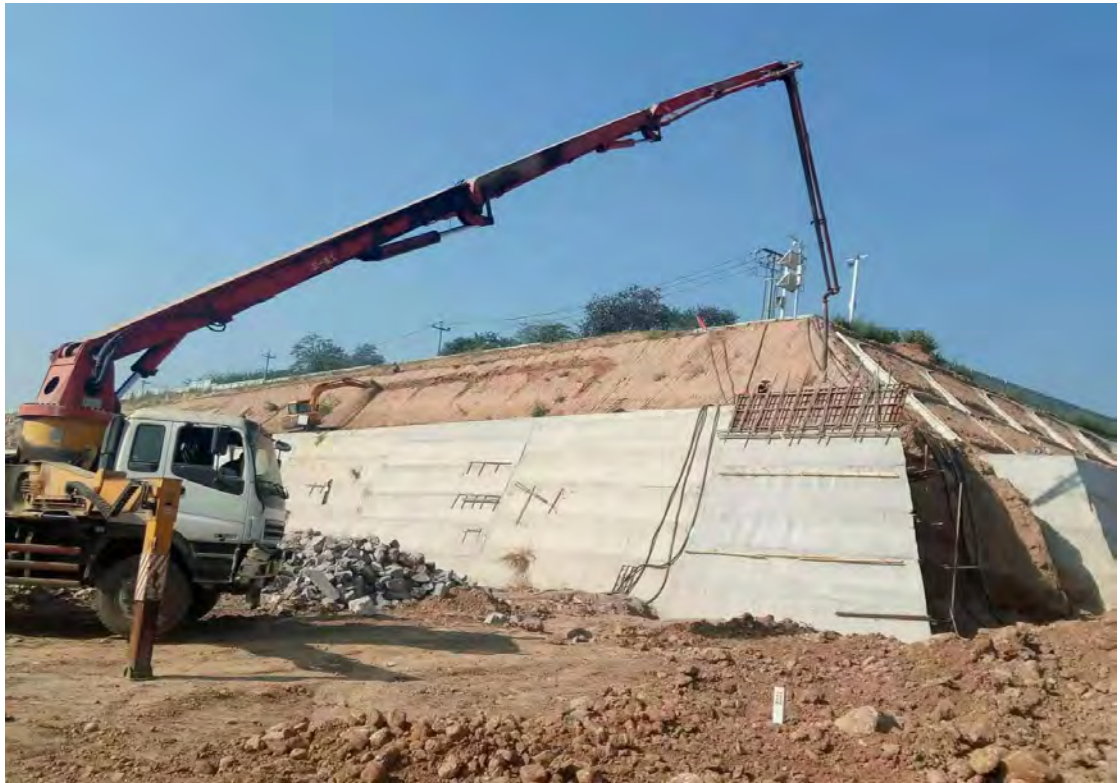
护坡工程（主生产区，2019.08）
