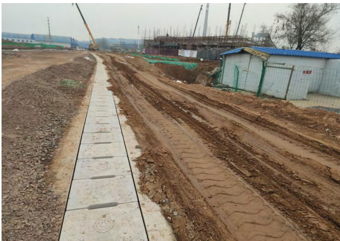
浆砌石排水沟（铁路专用线，2020.06）
