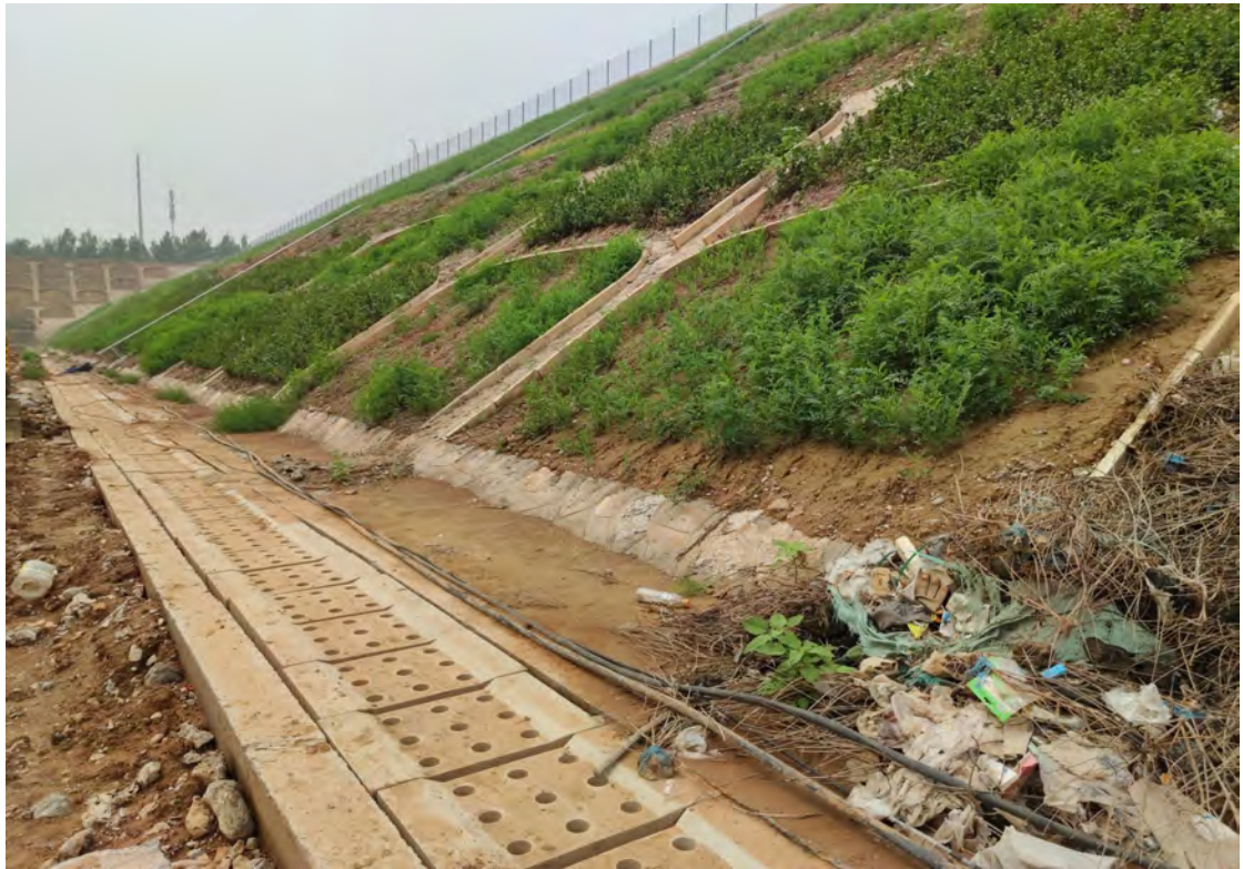
盖板排水沟和护坡工程（主生产区，2020.06）
