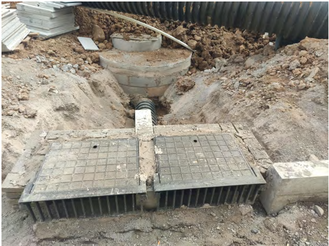
排水工程（主生产区，2020.10）
