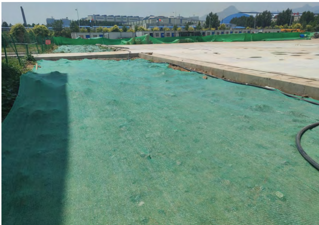
临时覆盖（铁路专用线，2021.03）
