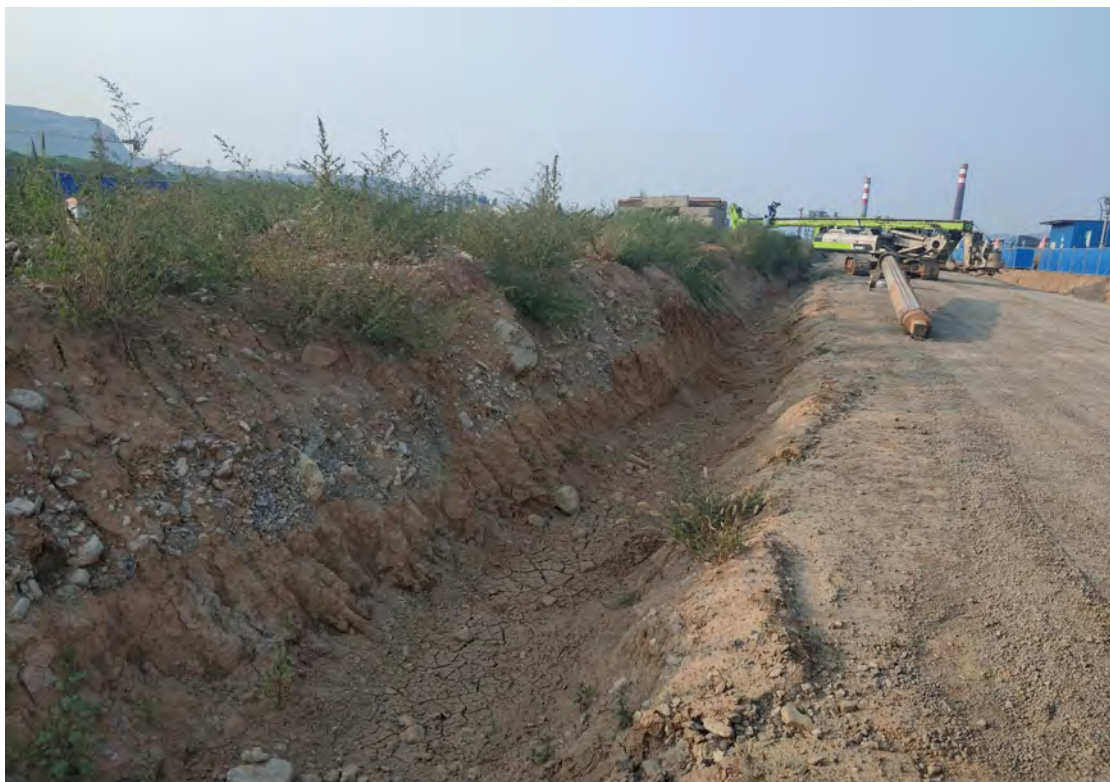
土质排水沟（主生产区，2019.07）
