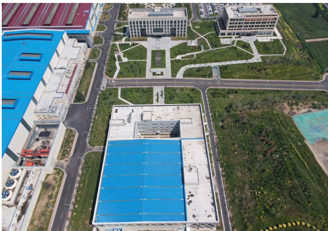
绿化工程（主生产区，2021.05）
