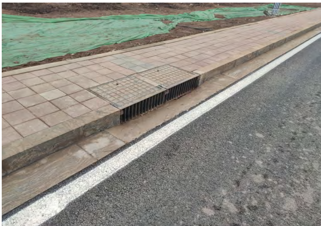
排水工程（主生产区，2020.12）
