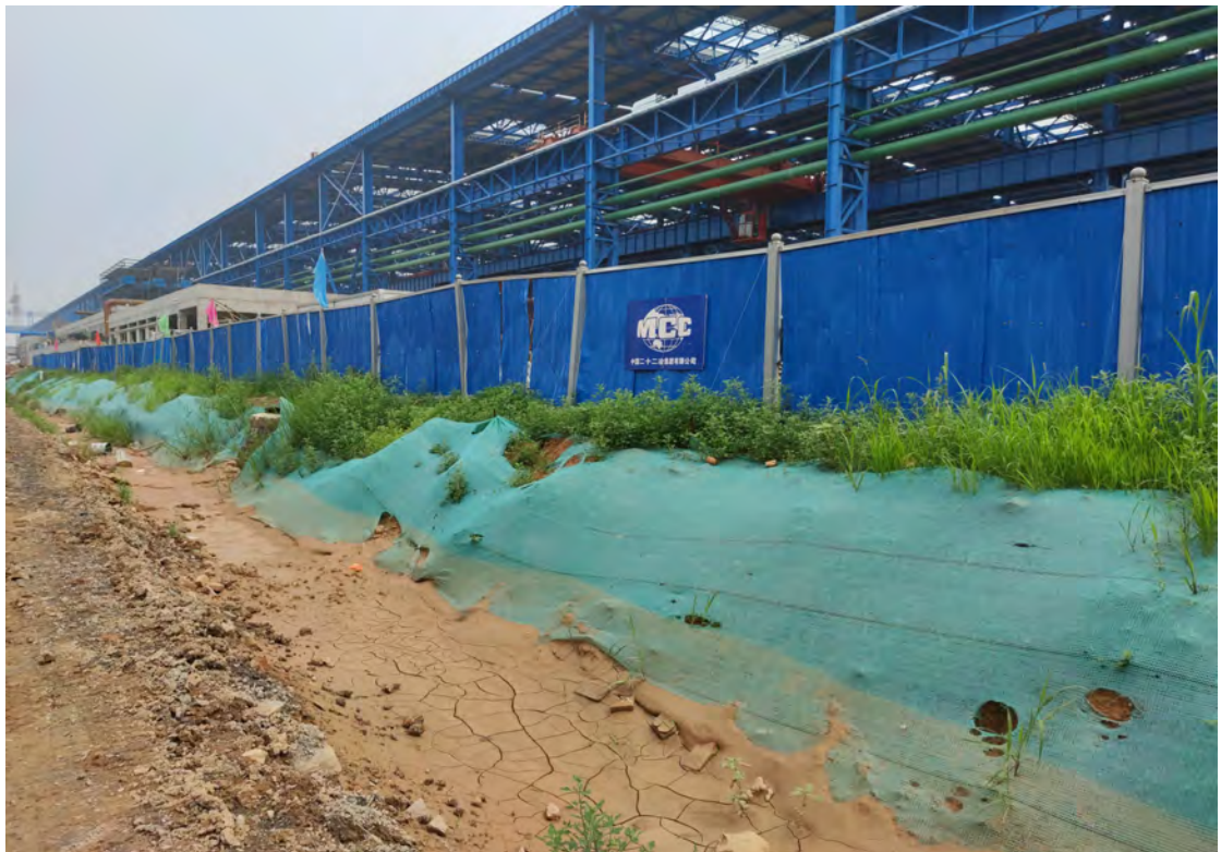
土质排水沟和临时覆盖（主生产区，2019.07）
