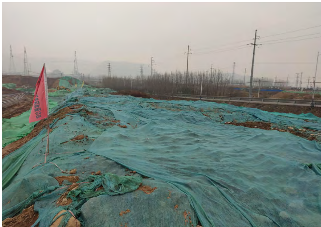
临时覆盖（主生产区，2019.06）
