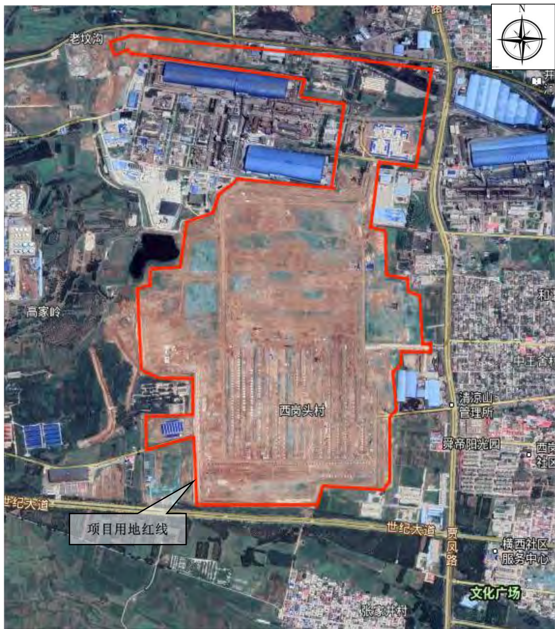
项目施工期遥感影像（2019.8）
