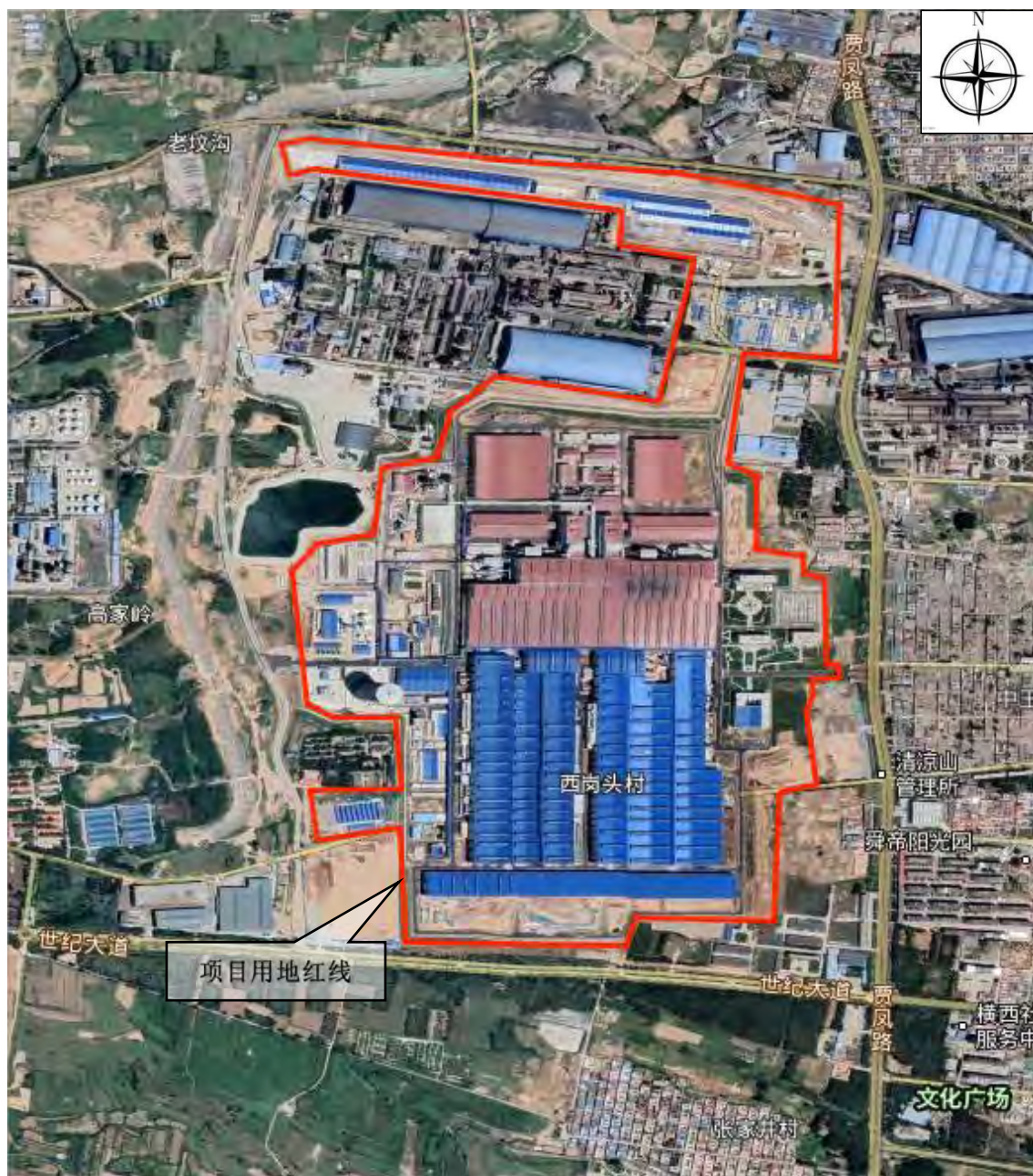
项目施工期遥感影像（2021.6）
