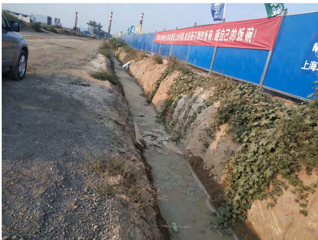
土质排水沟（主生产区，2019.07）
