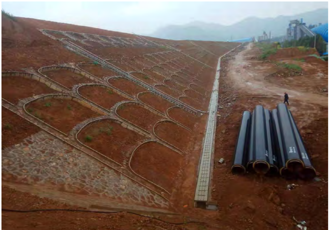
护坡工程（主生产区，2019.09）
