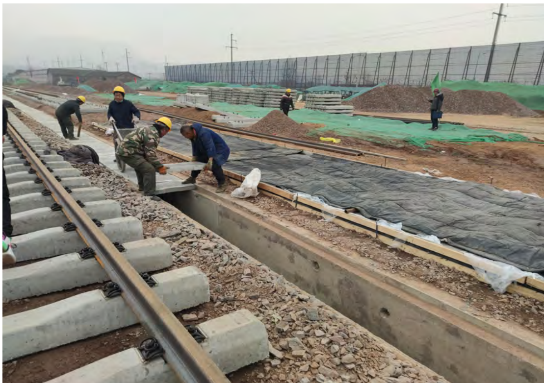
浆砌石排水沟（铁路专用线，2020.06）
