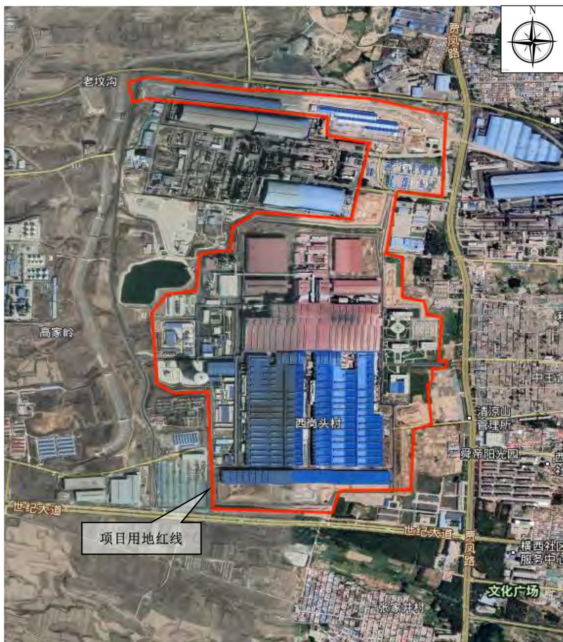
项目施工期遥感影像（2022.1）
