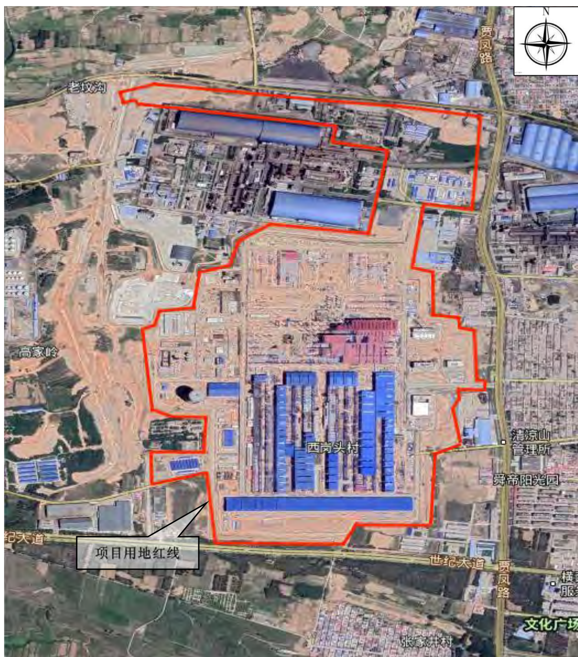
项目施工期遥感影像（2020.6）
