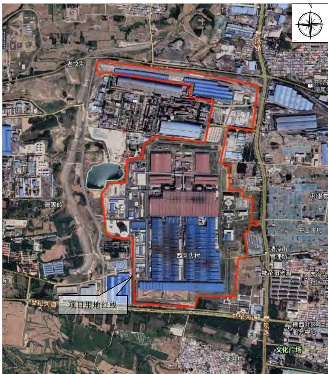
项目施工完遥感影像（2022.5）
