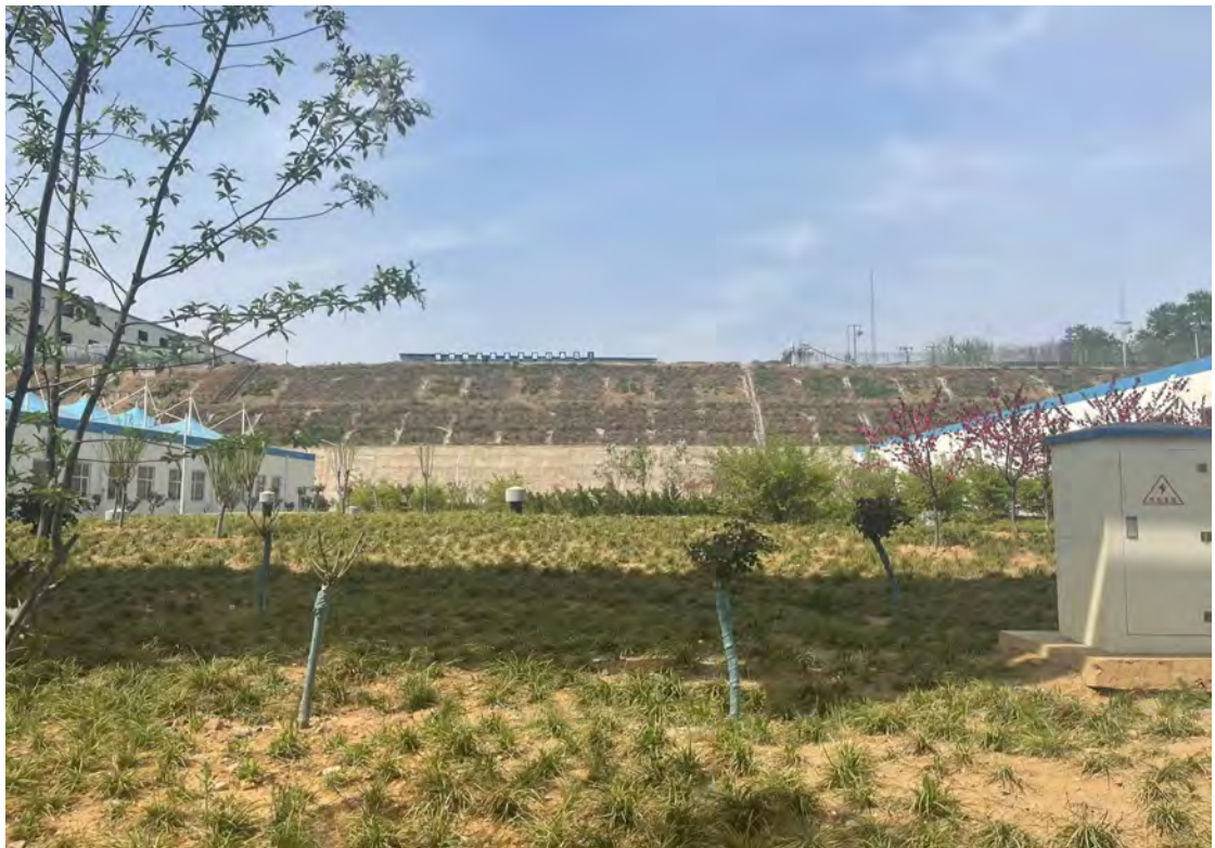
护坡工程及绿化工程（主生产区，2022.03）
