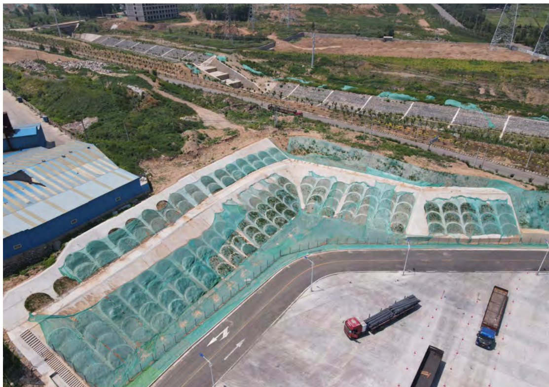
护坡工程（铁路专用线，2021.03）
