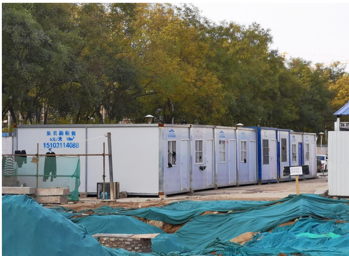
施工临建工程（拍摄时间：2021 年 9 月）
