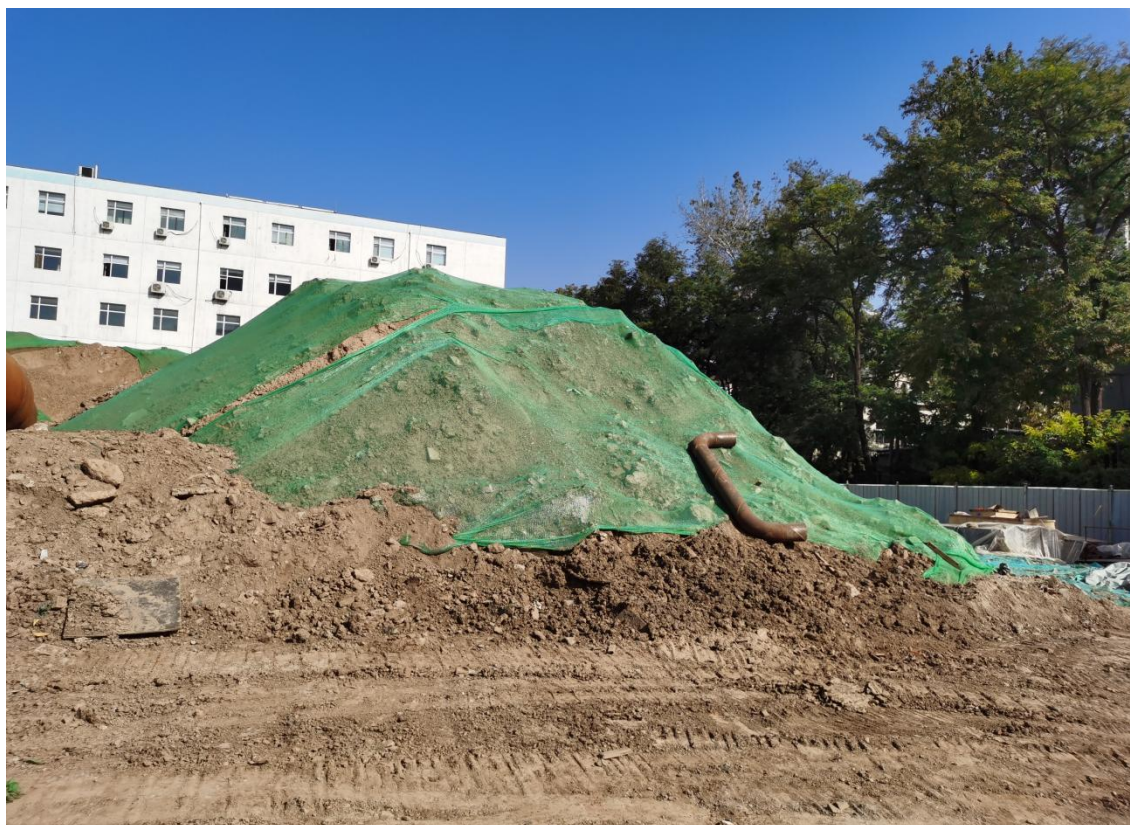
临时堆土苫盖（拍摄时间 2020 年 10 月）
