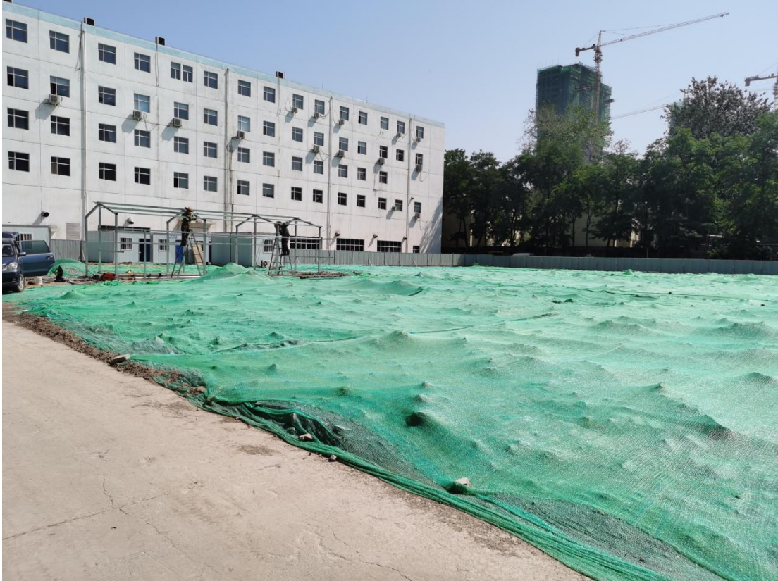
建构筑物工程遮盖（拍摄时间：2021年4月）
