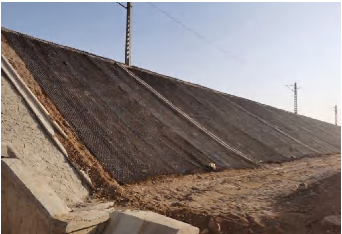
植物护坡施工（拍摄时间：2022年3月）
