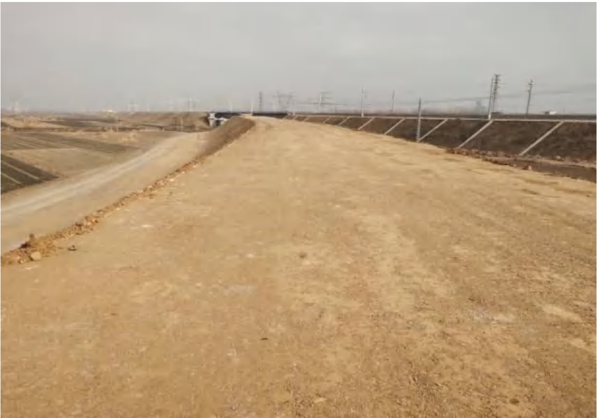
施工便道（拍摄时间 2021 年 9 月）
