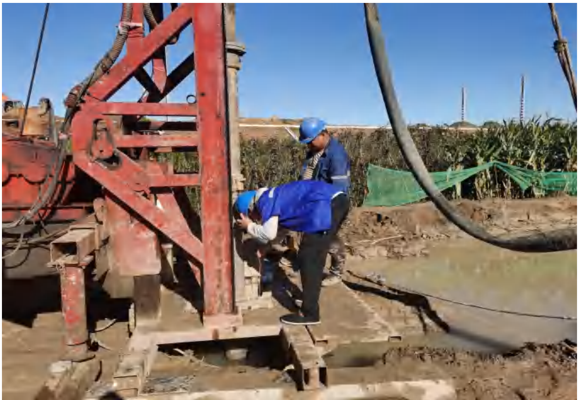
临时沉沙池、泥浆池（拍摄时间 2021 年 6 月）
