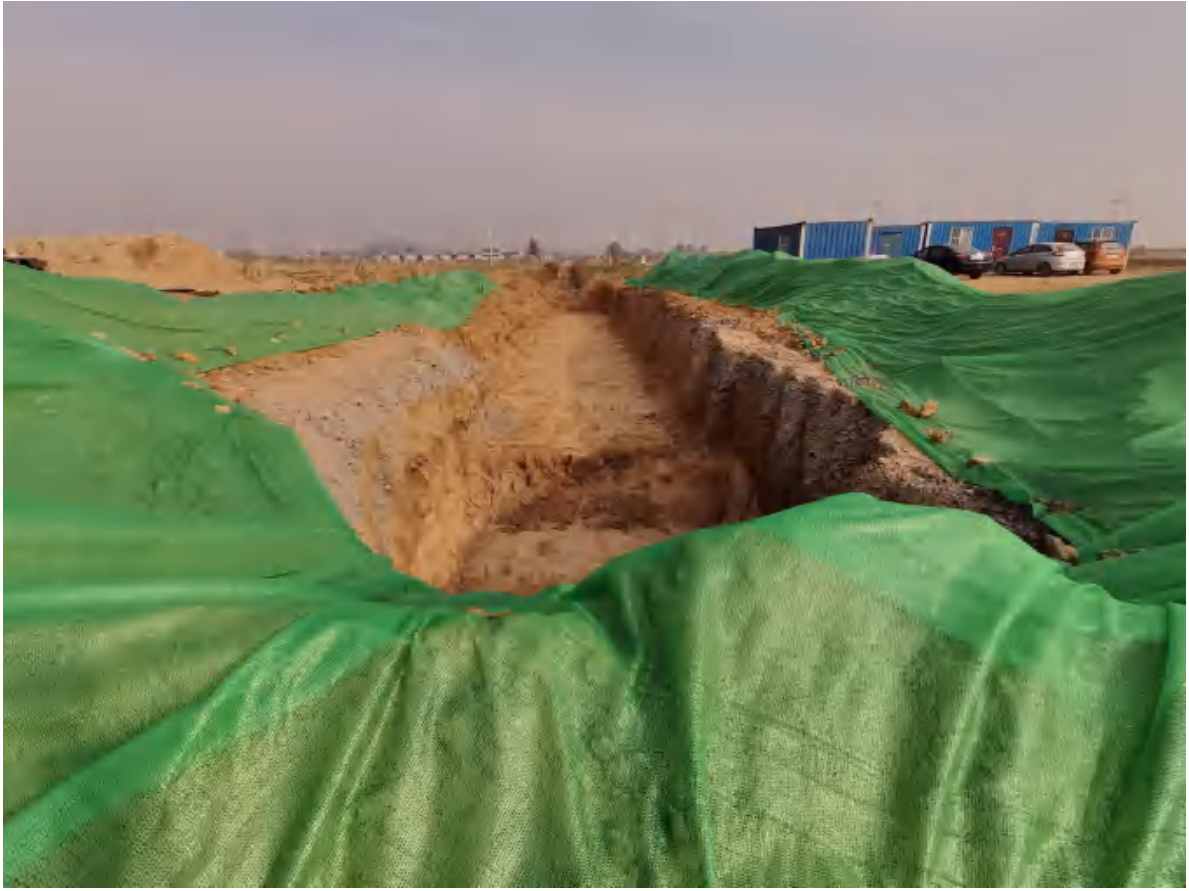
临时密目网苫盖（拍摄时间 2020 年 9 月）
