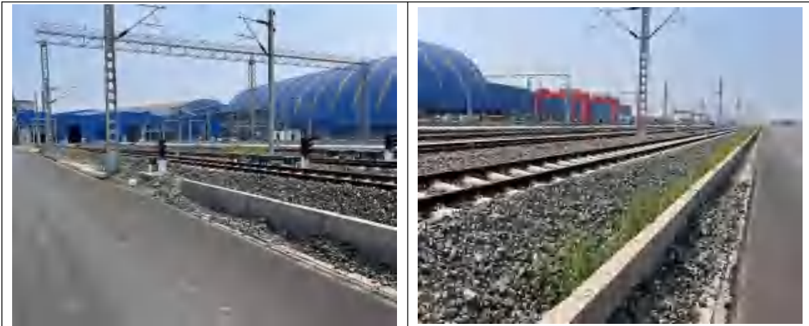
装卸场工程（浆砌石排水沟）
