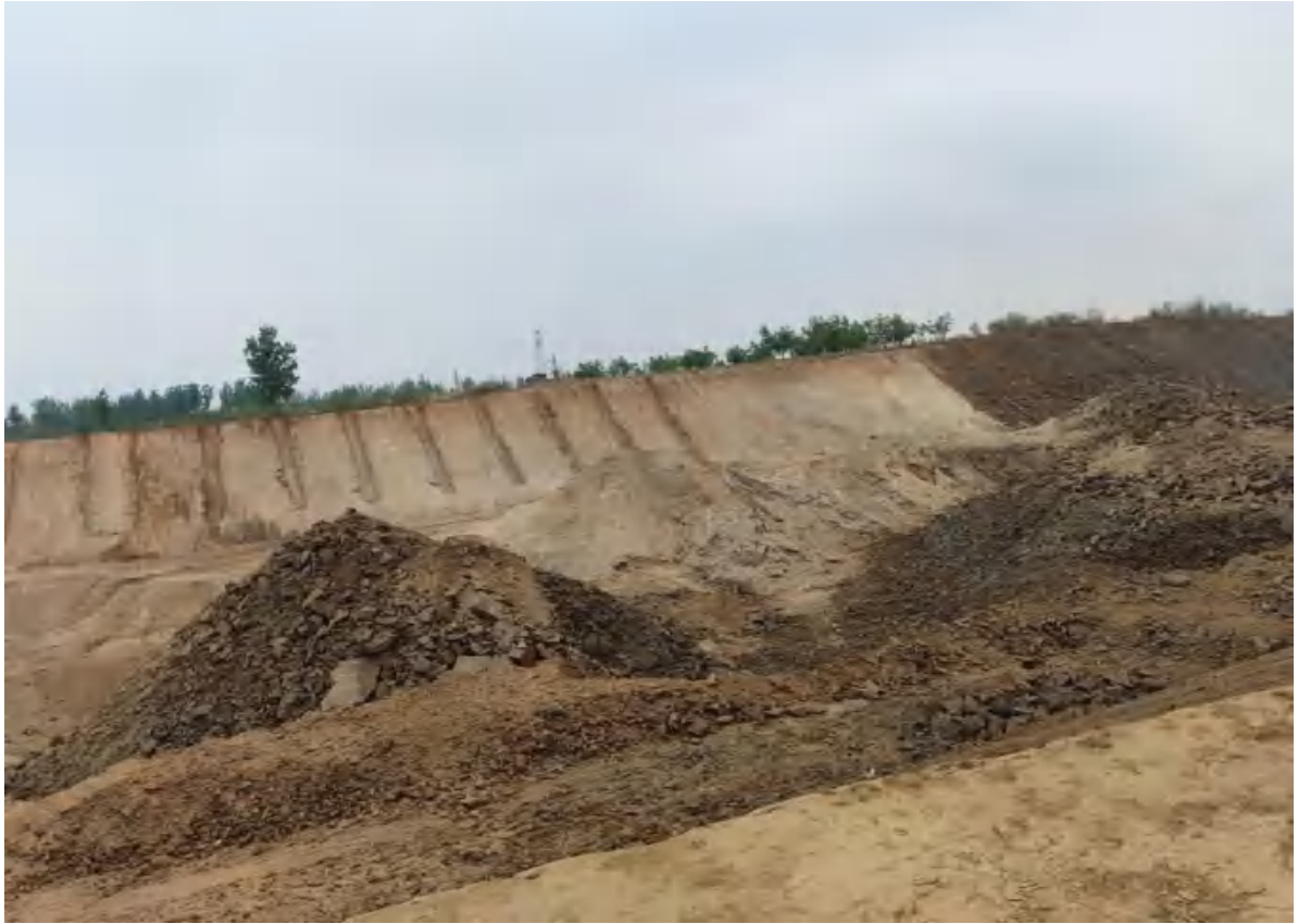
急流槽施工（拍摄时间：2021年12月）
