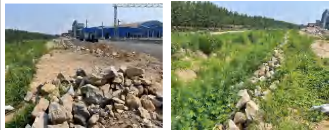
装卸场工程（裸露地表未苫盖、撒播草籽）
