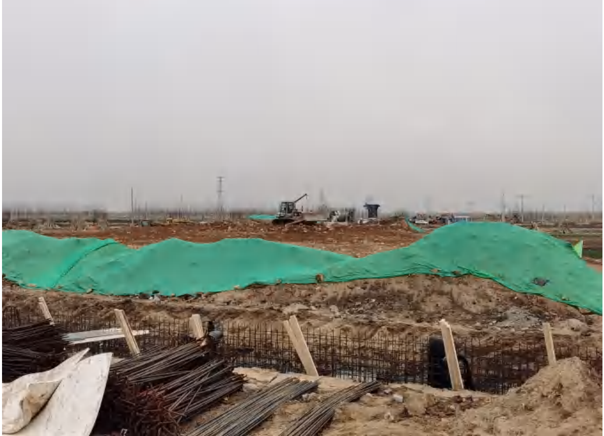
临时密目网苫盖（拍摄时间2021年3月）
