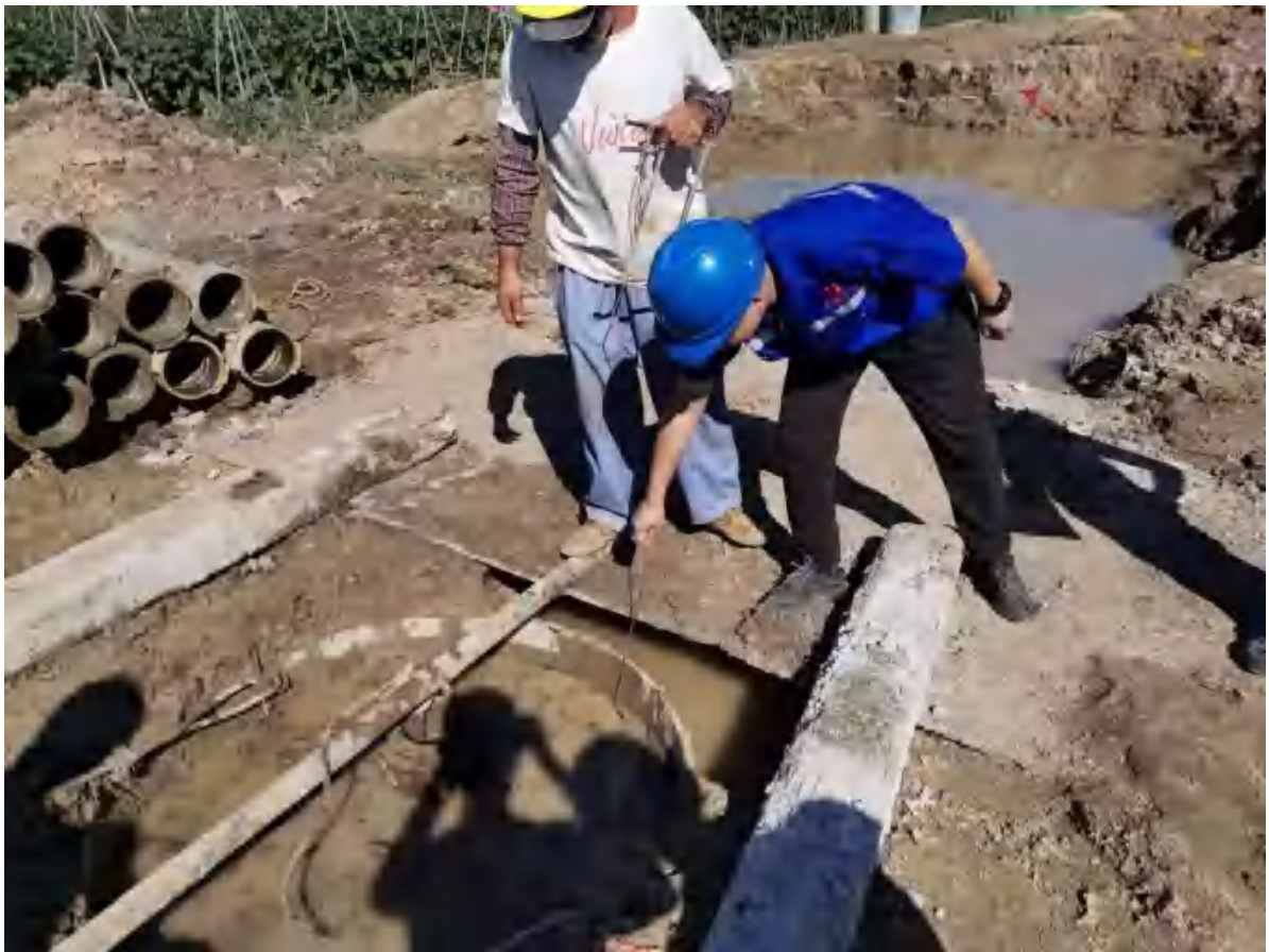
临时沉沙池、泥浆池（拍摄时间 2021 年 6 月）
