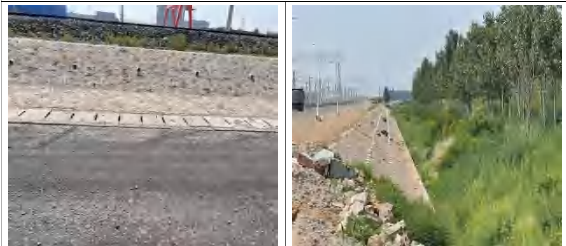
装卸场工程（浆砌石排水沟）
