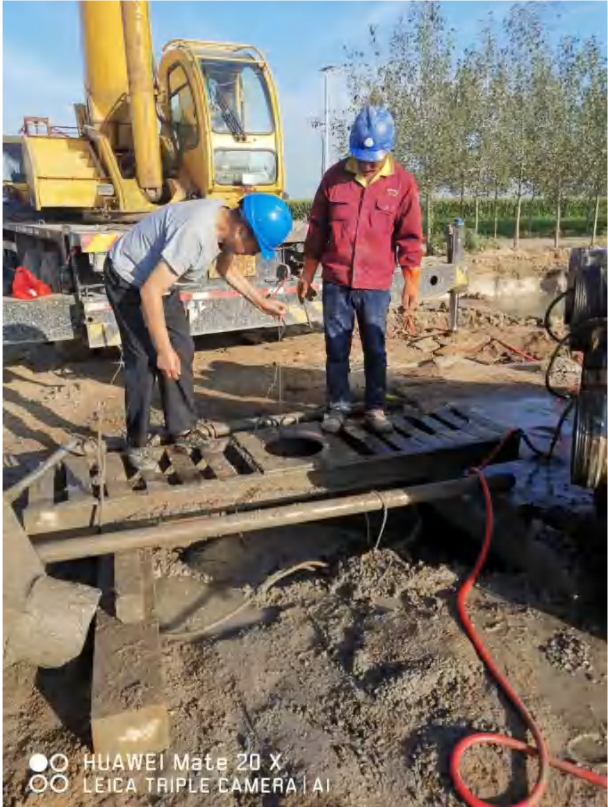
路基施工（拍摄时间：2021年5月）
