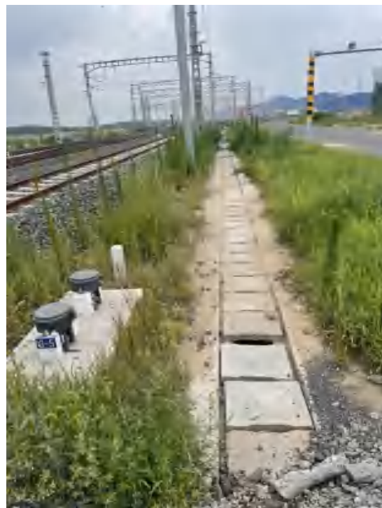
装卸场工程区-混凝土排水沟
