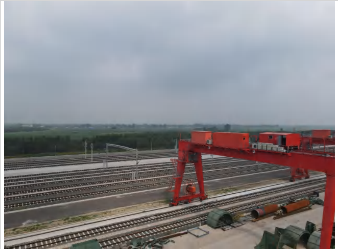
装卸场工程区
