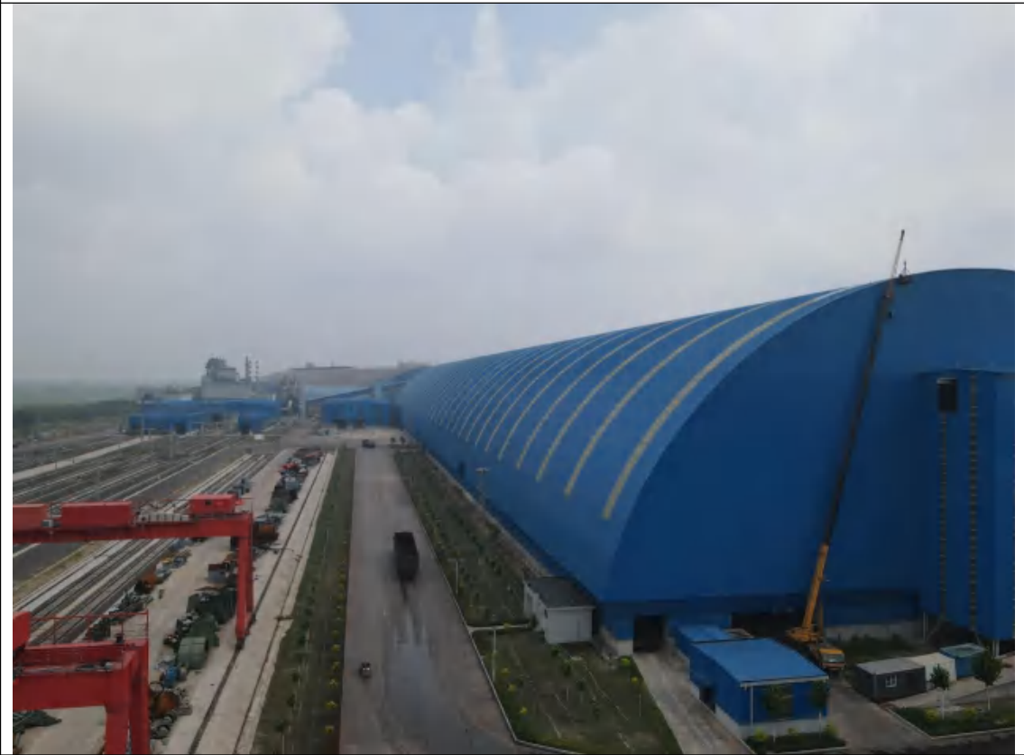
装卸场工程区
