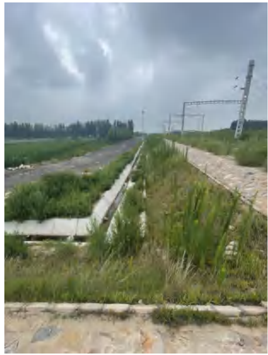
浆砌石防护、排水沟、绿化
