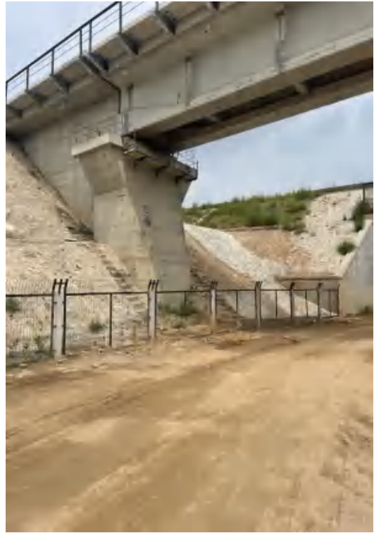
疏散线-浆砌石防护
