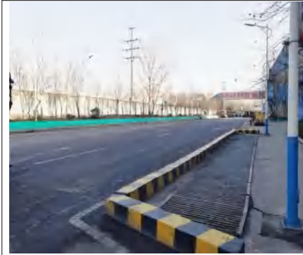
运输道路区-浆砌石排水沟
