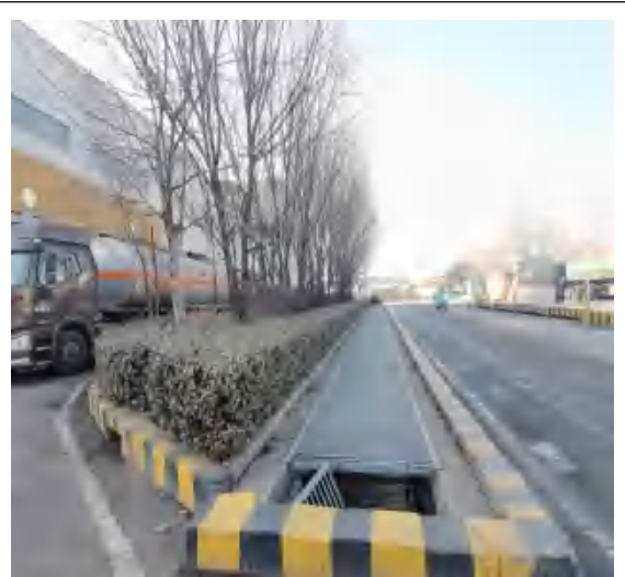
运输道路区-浆砌石防护
