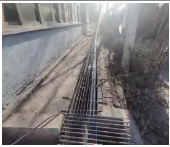
运输道路区-浆砌石排水沟
