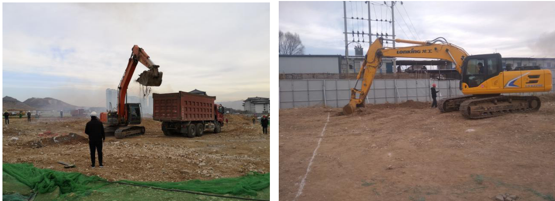
图 1 构建筑物基础开挖
