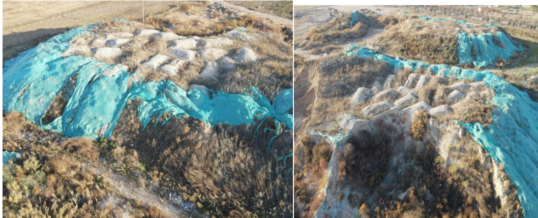
图4 临时堆土区苫盖
