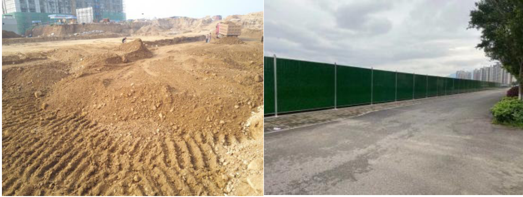
2017 年表土剥离、临时拦挡
