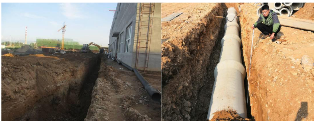
2018 年雨水管网管沟开挖及管网铺设
