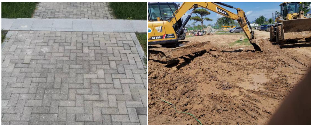
2018 年铺设透水砖、土地平整
