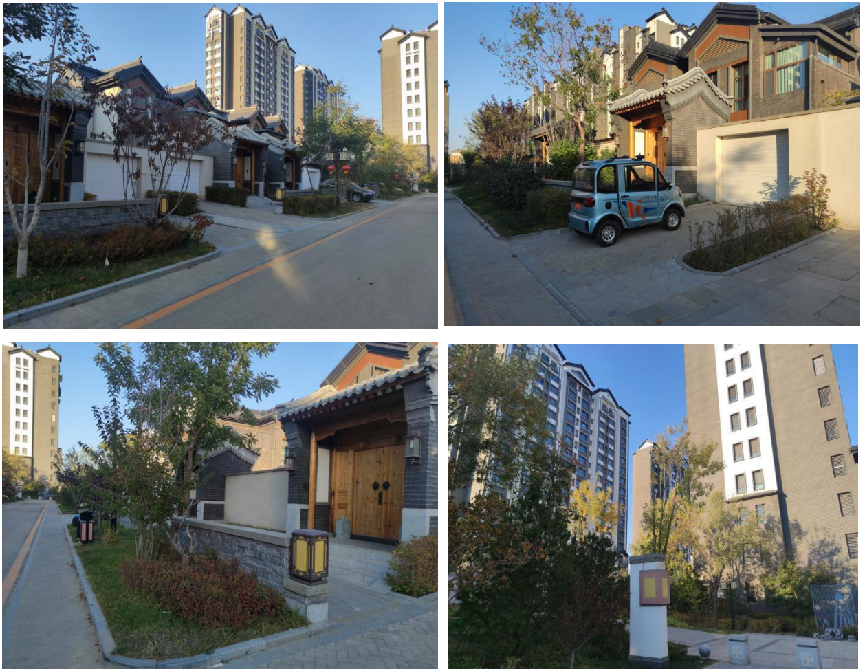
2022 年构建筑物区照片
