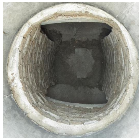
图10 站内道路区排水管（2017年6月）
