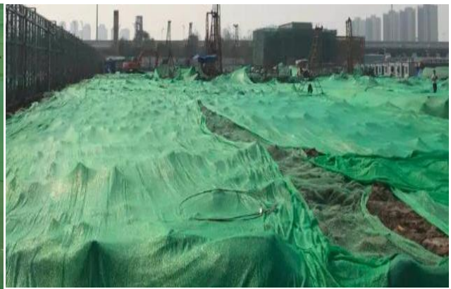
图 4 主体工程区苫盖 (2016 年 9 月)
