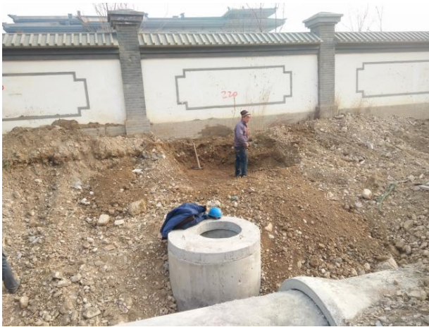
图9 站内道路区排水管（2017年5月）
