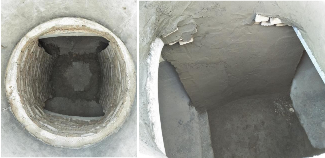
图3 排水管工程（2017年5月）
