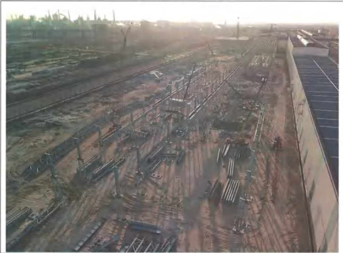
二期工程生产区房柱梁施工
