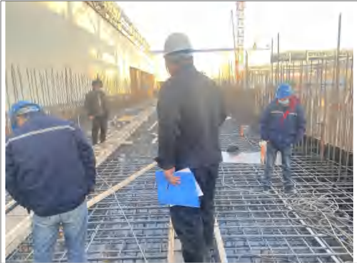
基础支模绑筋
