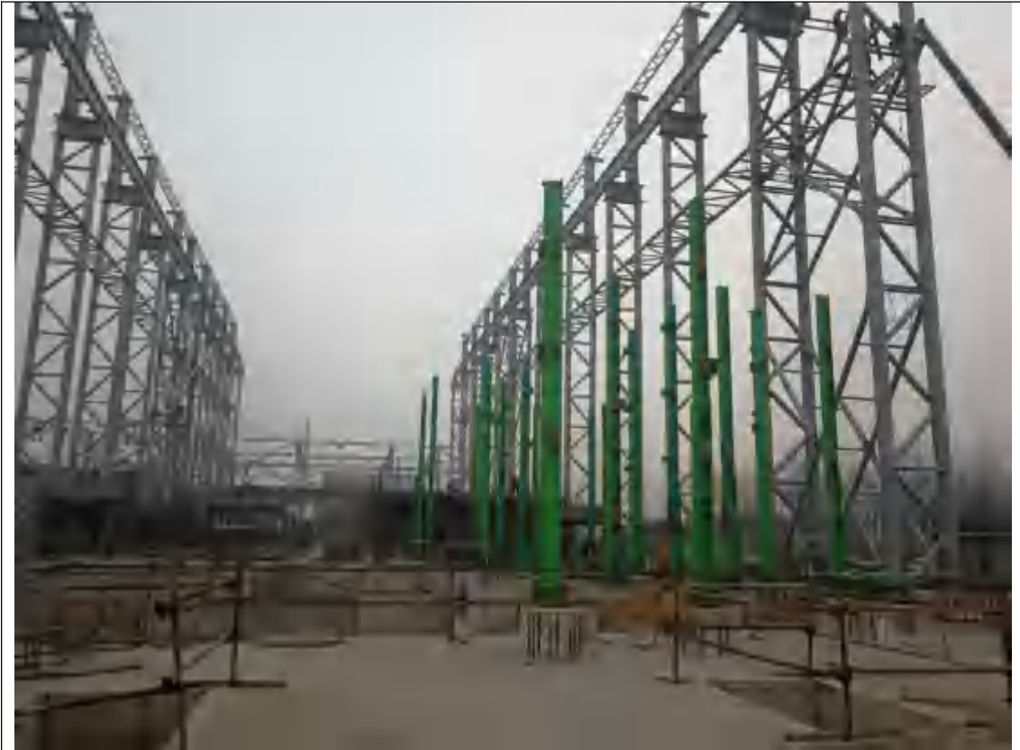
主体工程镀锌跨柱基础
