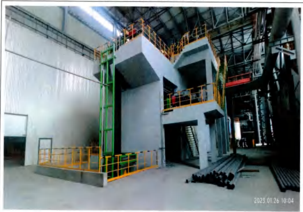
二期工程生产区设备安装
