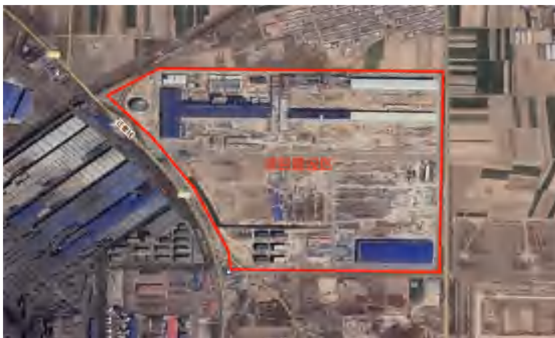
项目建设期遥感影像（2020.04）
