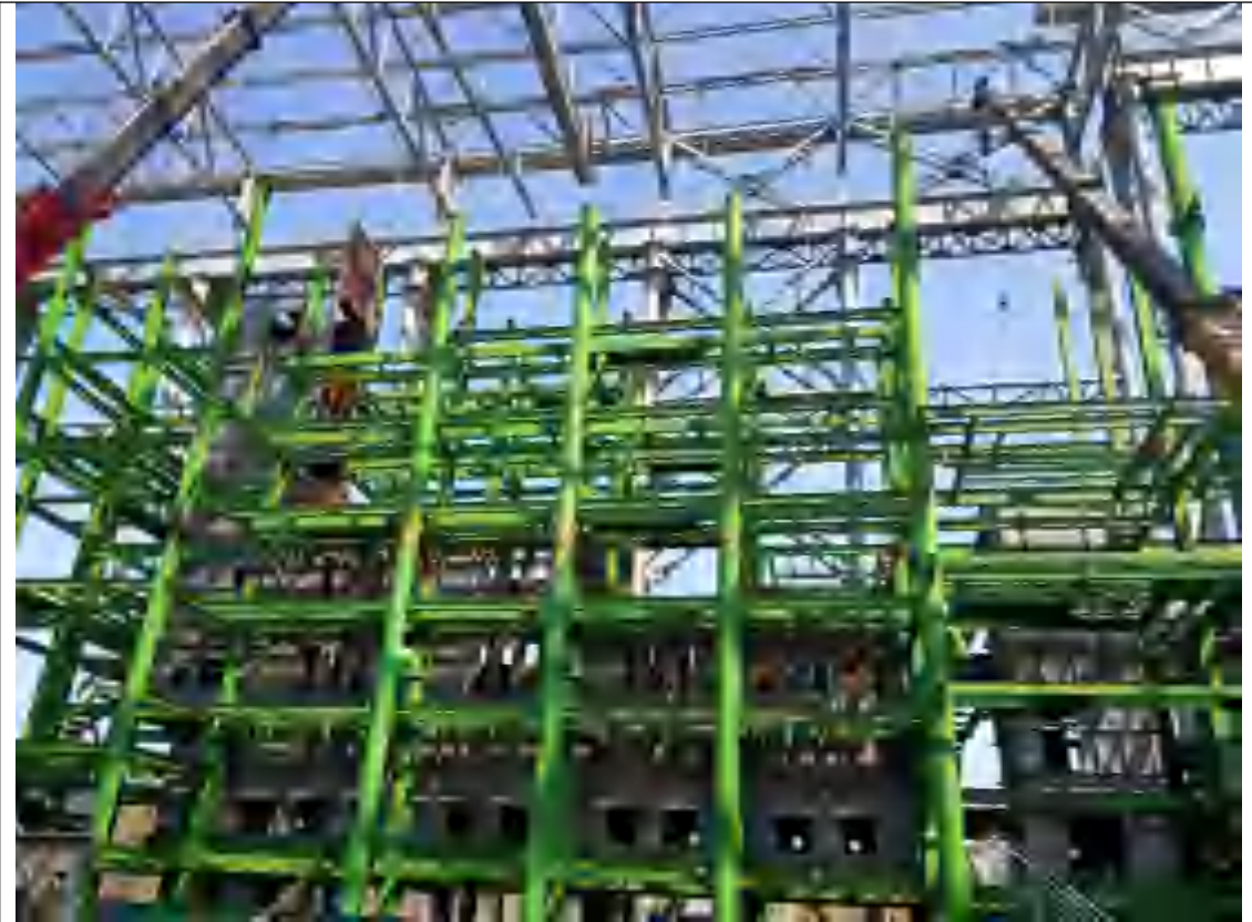
主体工程设备管道安装
