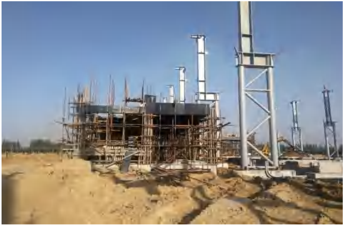
主体工程支模
