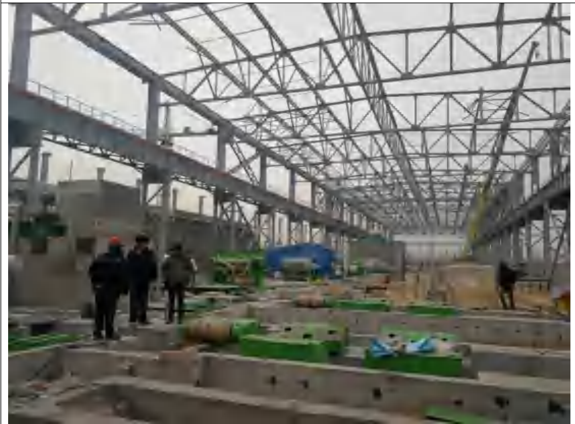
主体工程厂房钢结构安装
