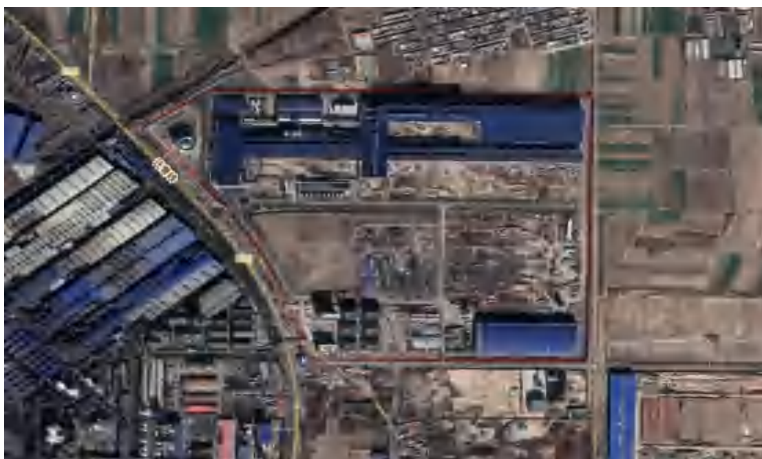
项目建设期遥感影像（2020.11）
