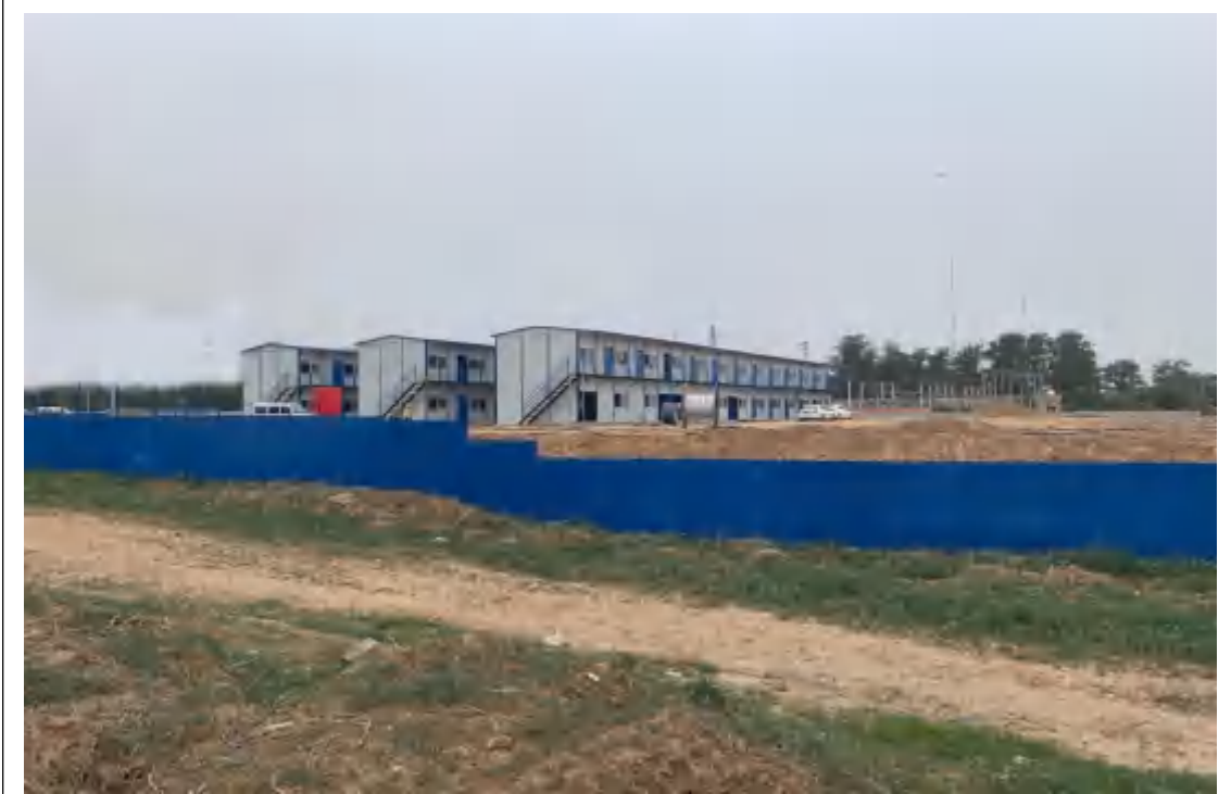
施工生产生活区
