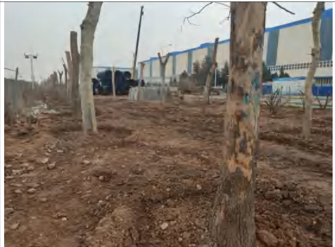
生产区绿化工程
