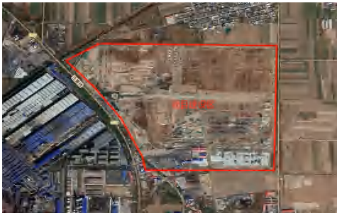
项目建设期遥感影像（2018.10）
