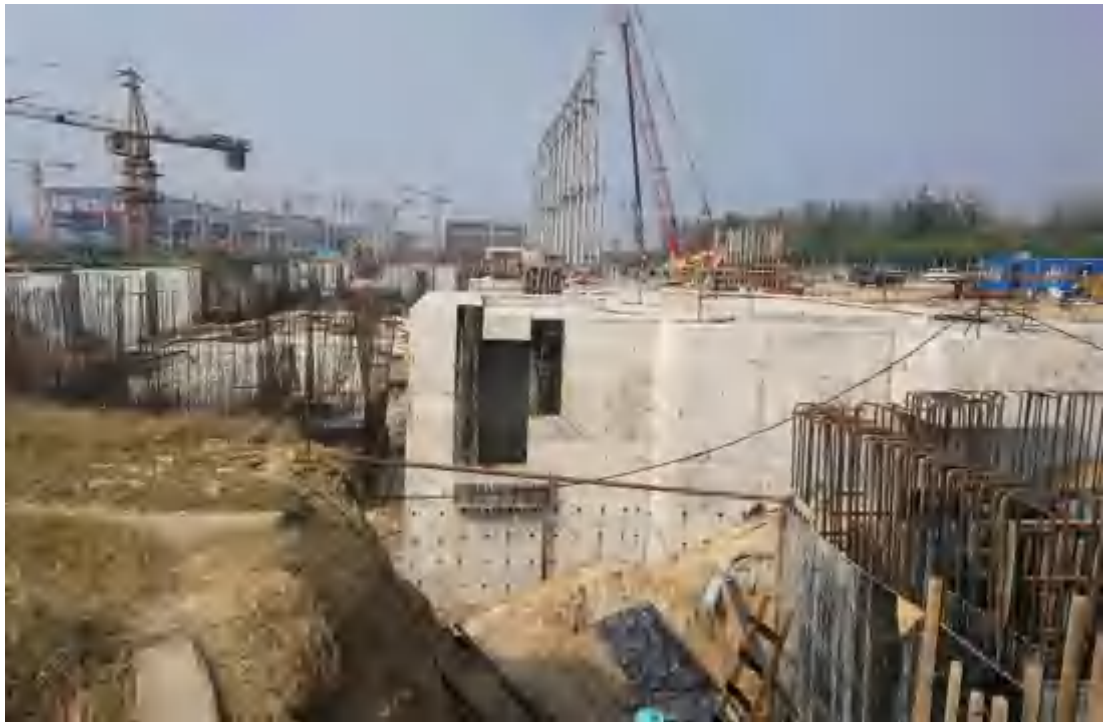
主体工程混凝土浇筑
