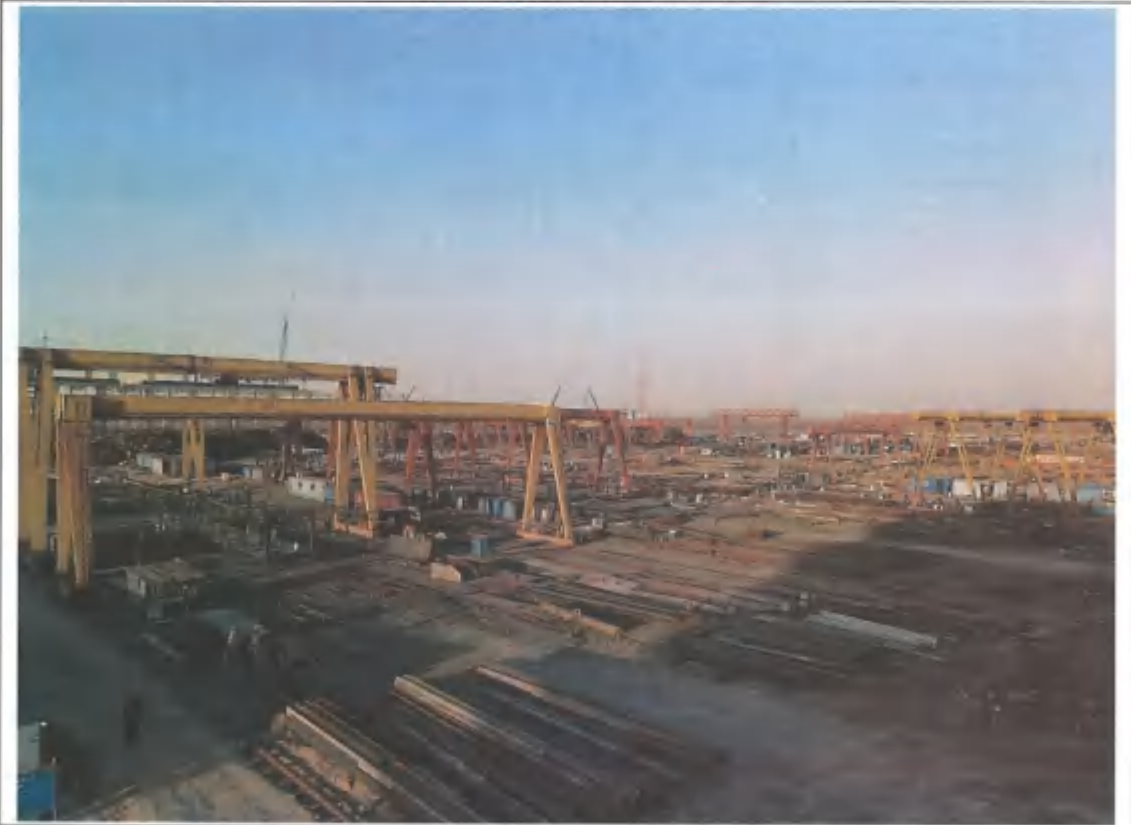
施工生产生活区
