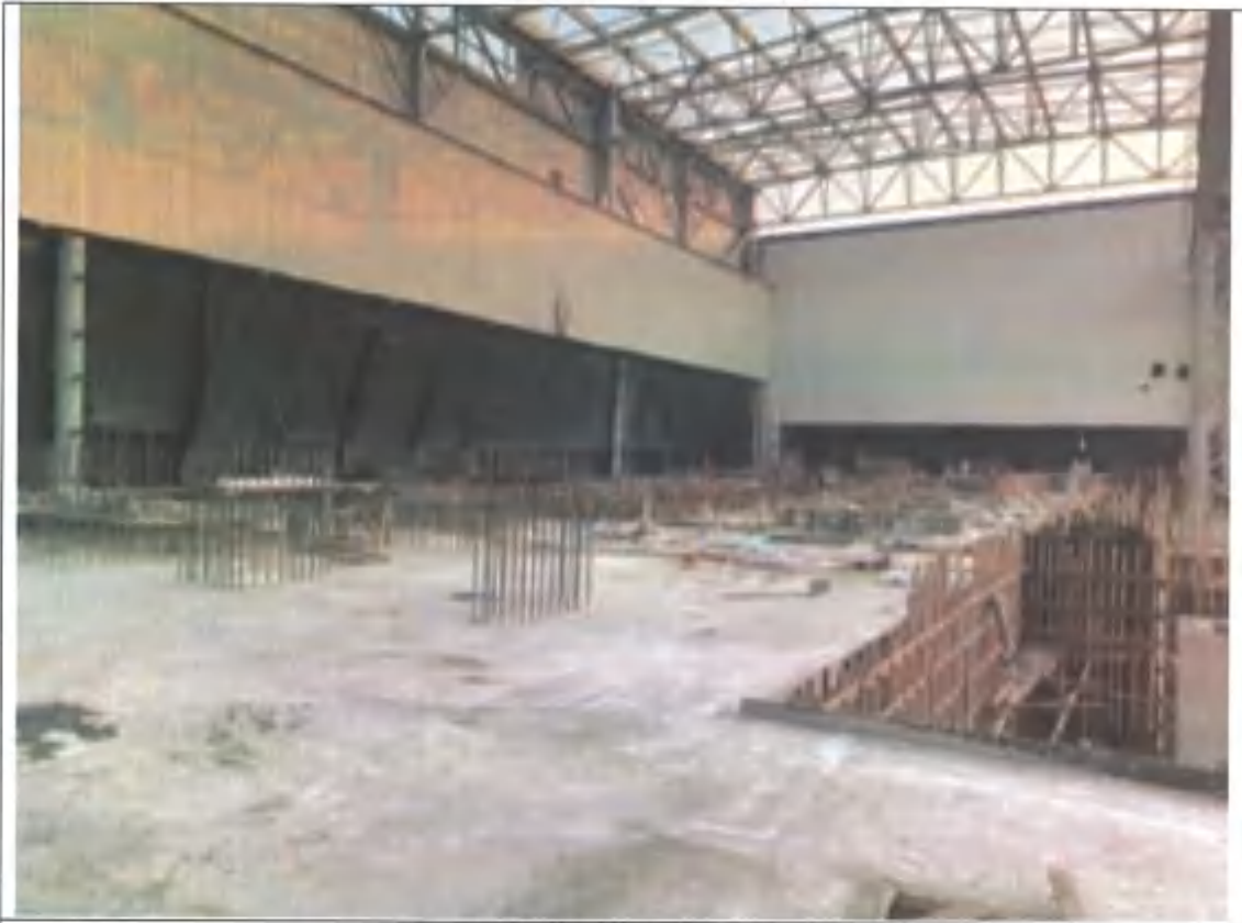
二期工程生产区绑筋及混凝土浇筑
