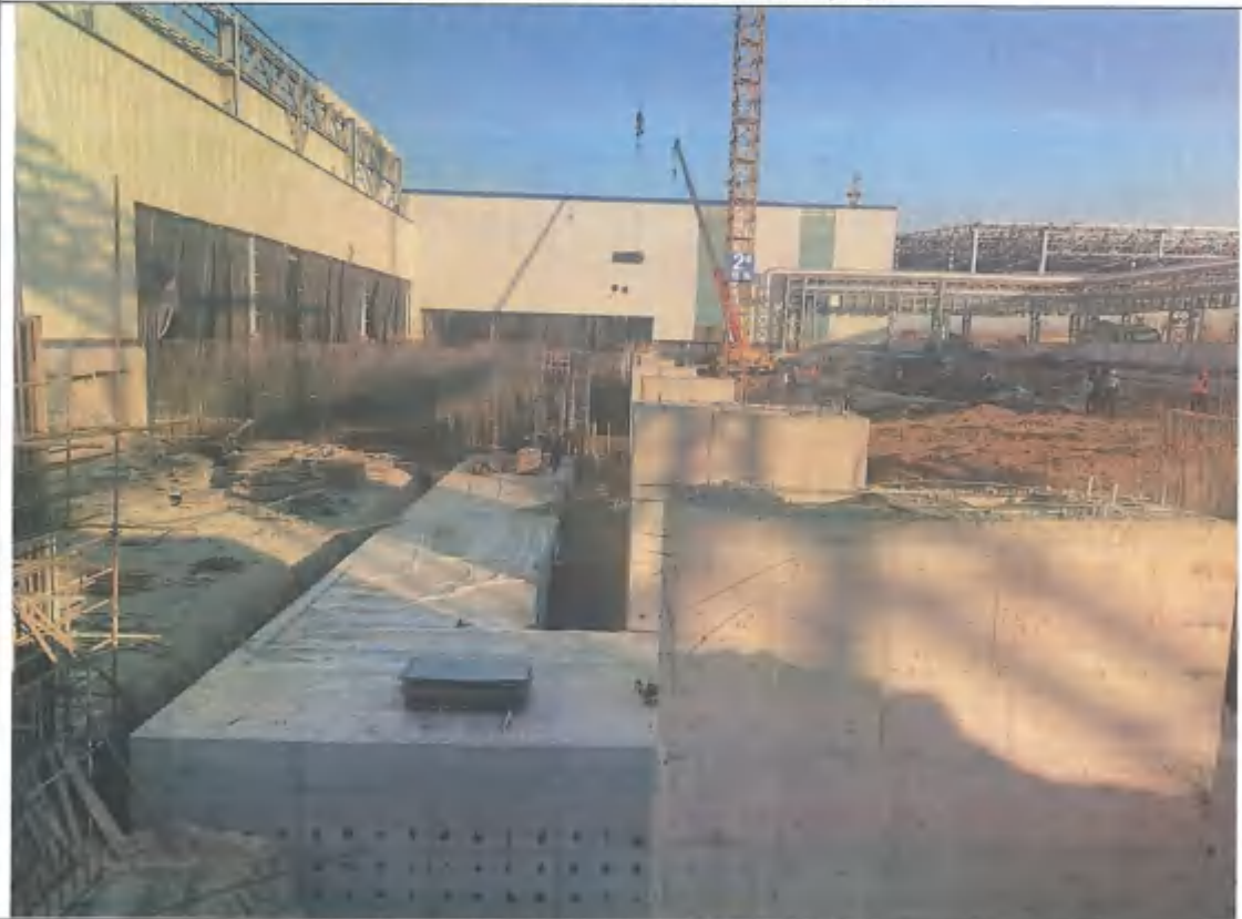
二期工程生产区混凝土浇筑
