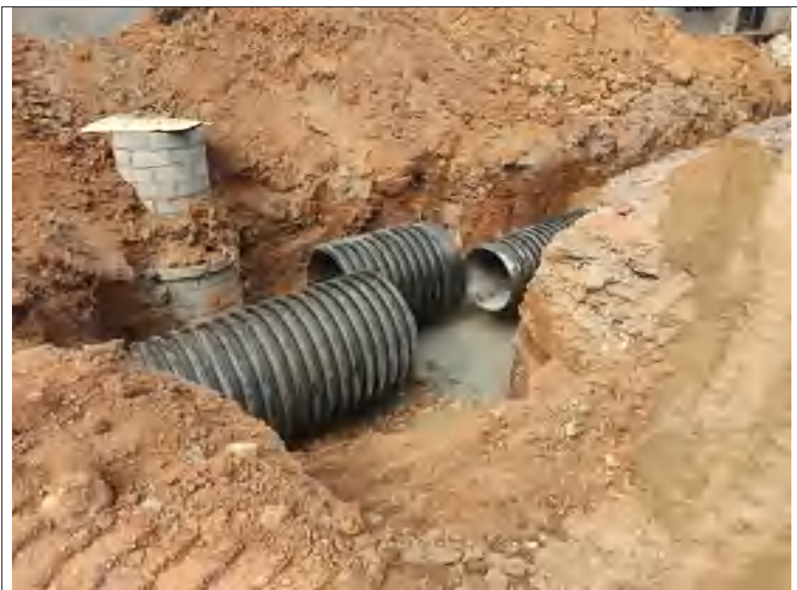
雨水管网建设
