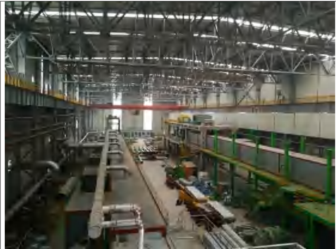
主体工程设备组装
