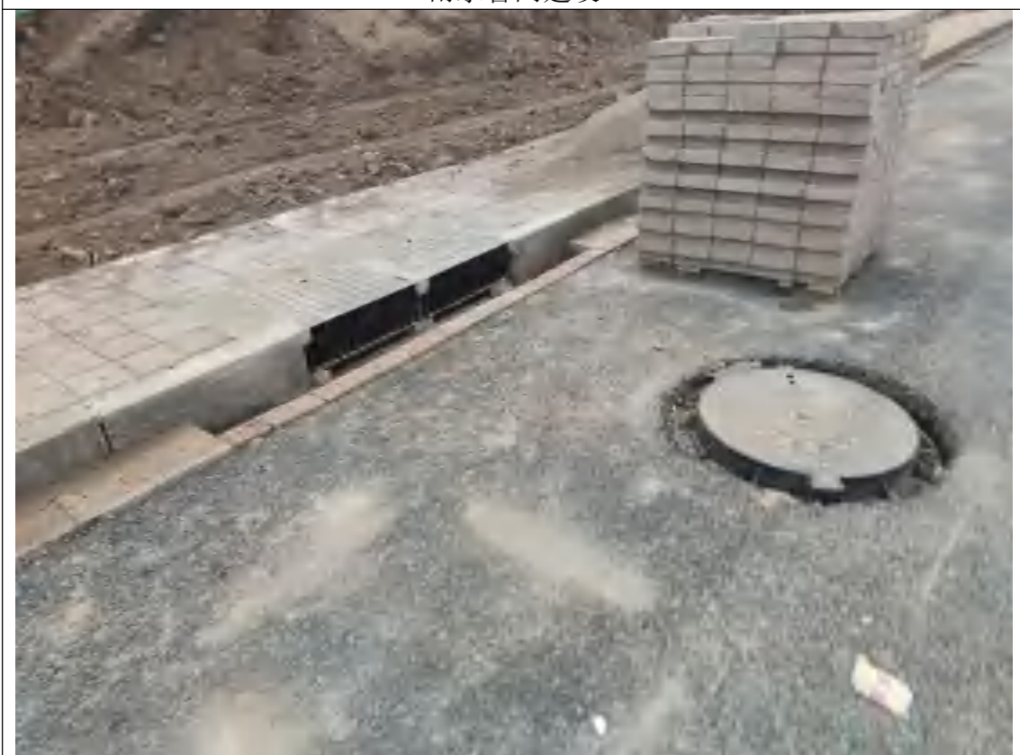
雨水管网建设
