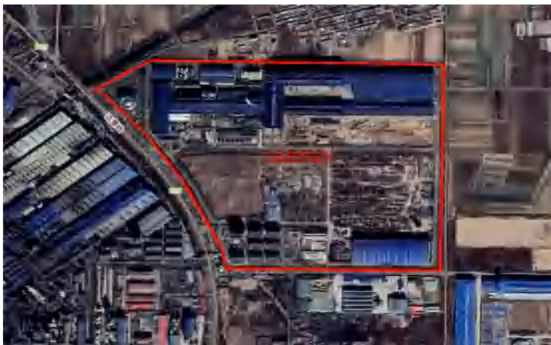
项目建设期遥感影像（2022.02）
