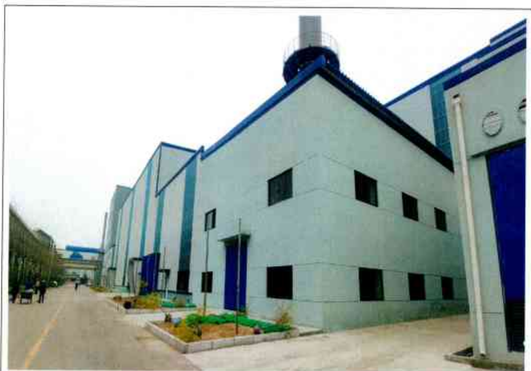
二期工程绿化及硬化施工
