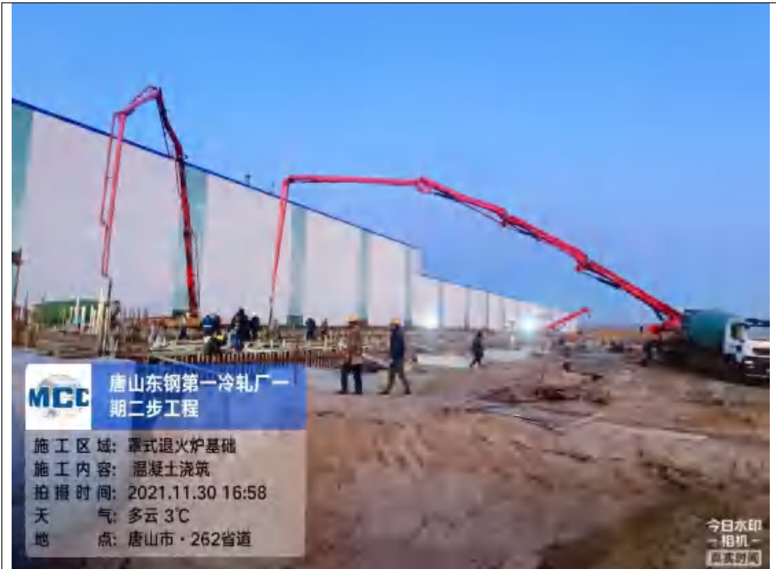
底板浇筑混凝土
