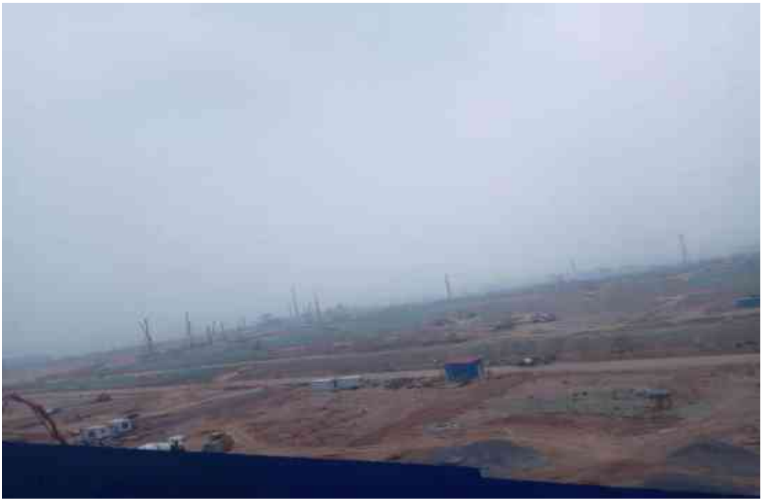
主体工程施工
