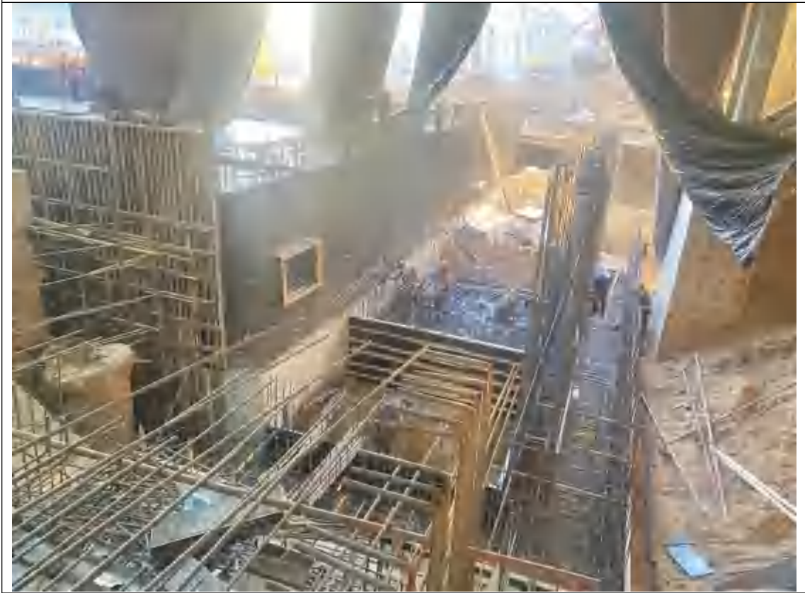
基础支模绑筋
