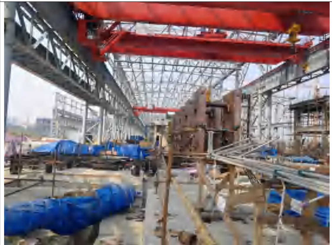
主体工程架杆及钢结构组装
