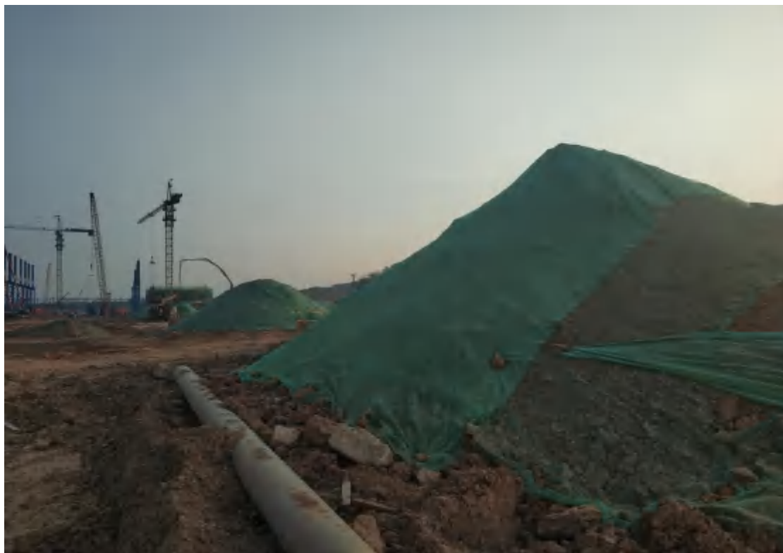
堆土临时苫盖（调查时间2020年4月）
